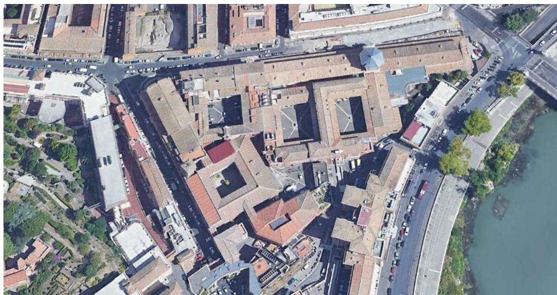
Imagen 5. Vista satélite del antiguo hospital de la orden Sancti Spiritus en Roma. © imag. Google Earth . Se aprecia la cúpula octogonal y las dos enfermerías a los lados.
