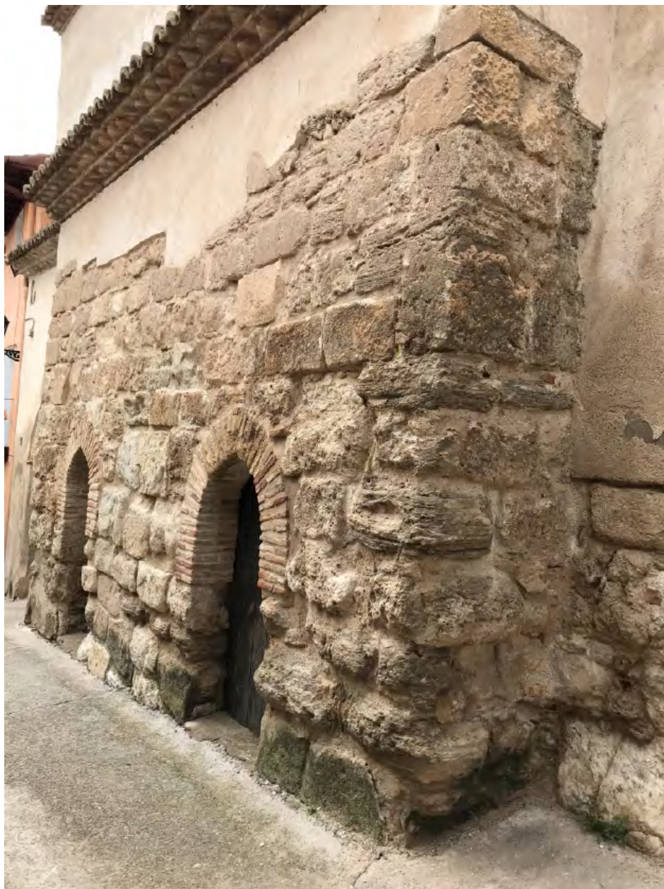
Fig. 12. Fachada de la Ermita de la Virgen de la Consolación, antigua sinagoga. Se aprecian los sillares de caliza con modulación romana procedentes de edificaciones bilbilitanas (Foto: Archivo del CEB).
