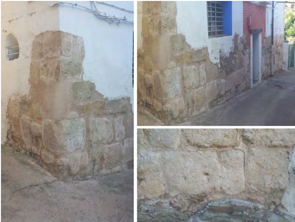
Fig. 13. Huérmeda (c/ Real 2) construido en su primera planta con sillares romanos. Detalle de uno de ellos que conserva las perforaciones laterales para afianzar las garras ( ferrei fortines ) que posibilitan su colocación (Fotos: Carlos Sáenz).
