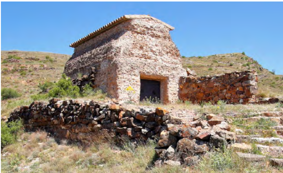
Fig. 3. Ermita de San Paterno. Antigua cisterna romana. Se aprecia cómo está realizada toda ella en opus caementicium (Foto: Carlos Sáenz).
