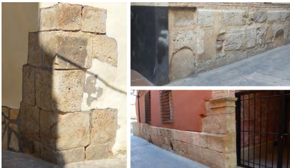
Fig. 14. Muestra de reutilización de sillares romanos en algunos muros de los palacios de las c/Gotor y plaza Erueta ( Palacio de Erueta, Palacio Sesé y Palacio Pujadas ) (Fotos: Carlos Sáenz).
