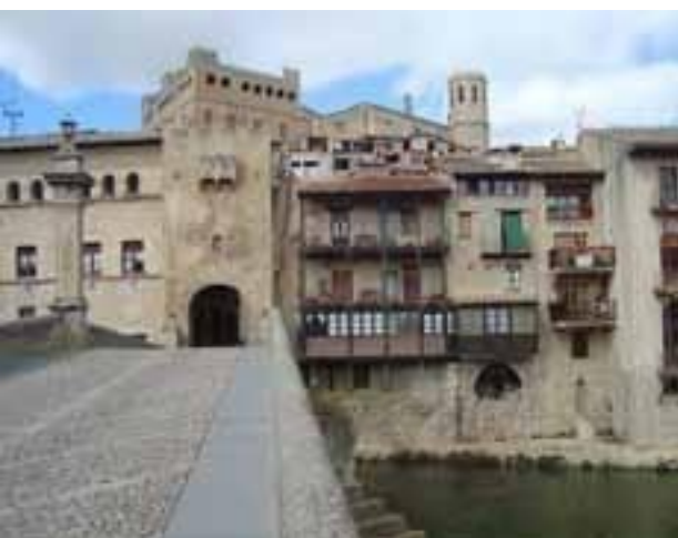
Valderrobres, exterior view.
