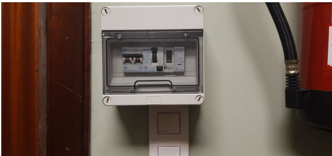
Fig. 12. Cuadro con diferencial eléctrico. Fuente: Fotografía realización propia
