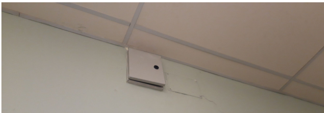
Fig. 11. Falso techo y cajas de registro y empalmes eléctricos. Fuente: Fotografía realización propia
