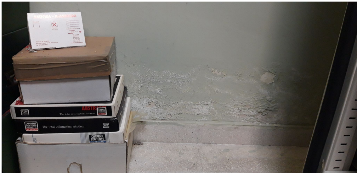
Fig. 17. Manchas de humedad en la pared del depósito cerca del compacto. Fuente: Fotografía realización propia
