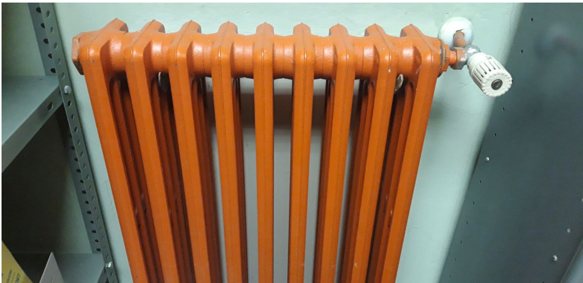
Fig. 13. Radiador con regulador de temperatura. Fuente: Fotografía realización propia
