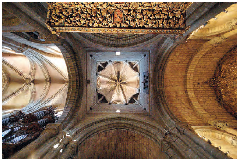
Figs. 46a y 46b. Ávila. San Vicente. Exterior desde la cabecera, e interior, con el sistema de cierre del cimborrio. Fotos: Javier Ibáñez Fernández.
