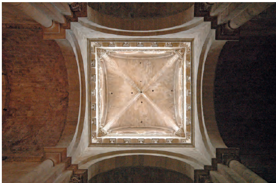
Figs. 42a y 42b. Coímbra (Portugal). Catedral vieja. Exterior desde la cabecera, incluyendo el cimborrio medieval, con la solución cupulada posterior; e interior, con el sistema de cierre del lucernario. Fotos: Javier Ibáñez Fernández.
