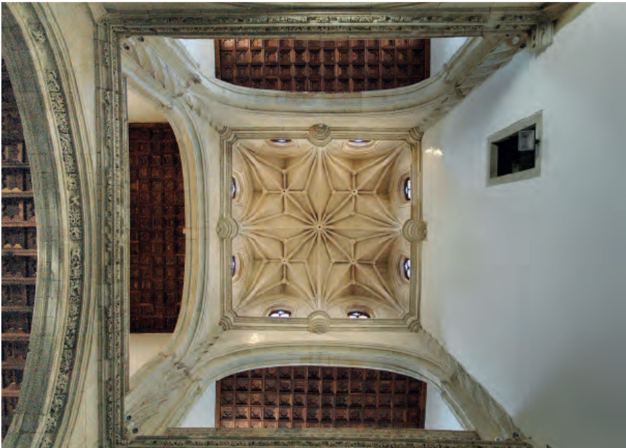
Figs. 99a y 99b. Santiago de Compostela (La Coruña). Hospital Real. El cimborrio desde uno de los patios, y detalle de su sistema de abovedamiento. Fotos: Javier Ibáñez Fernández.
