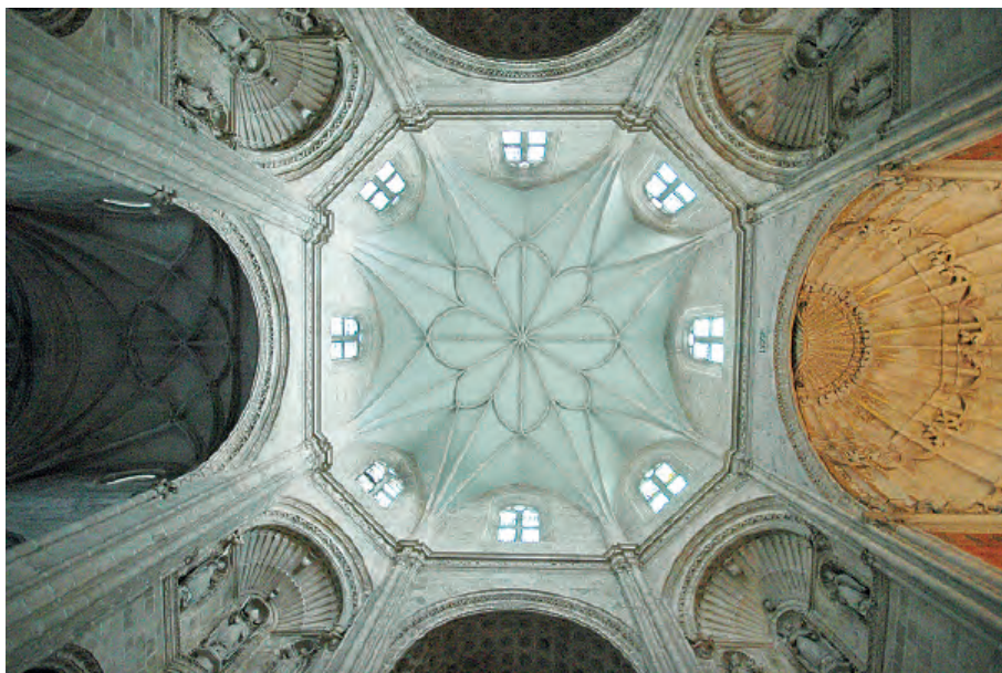
Fig. 153. Monasterio de La Vid (Burgos). Iglesia. Detalle de la soluciones de abovedamiento de la cabecera. Foto: Javier Ibáñez Fernández.
