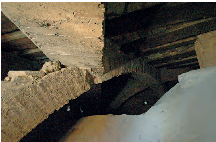
Fig. 117. Zaragoza. Catedral. Cimborrio. Segunda red de arcos entrecruzados, tendida sobre el trasdós de la bóveda del tambor, visible a la derecha y en la parte inferior de la imagen. Foto: Javier Ibáñez Fernández.
