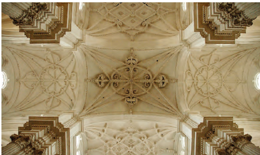
Fig. 130. Granada. Catedral. Bóveda de crucería volteada sobre el tramo correspondiente a la encrucijada del transepto occidental en el siglo XVIII. Foto: Javier Ibáñez Fernández.
