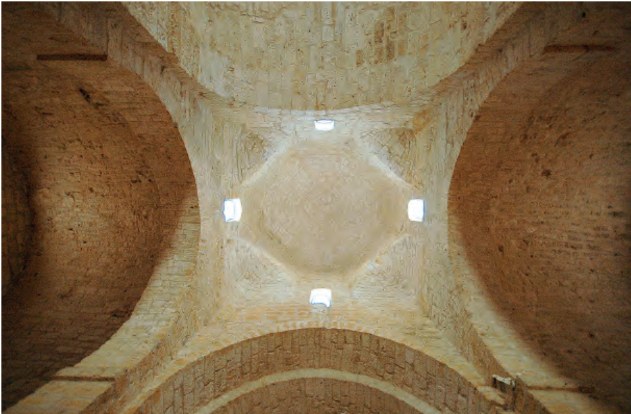
Figs. 20a y 20b. Urueña (Valladolid). Iglesia de Santa María de la Anunciada. Exterior desde los pies, e interior, con el sistema de cierre del cimborrio. Fotos: Javier Ibáñez Fernández.
