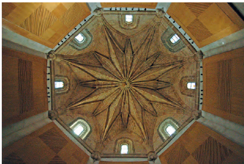
Fig. 84. Ávila. Iglesia conventual de San Francisco. Capilla de San Antonio. Detalle del sistema de abovedamiento. Foto: Javier Ibáñez Fernández.
