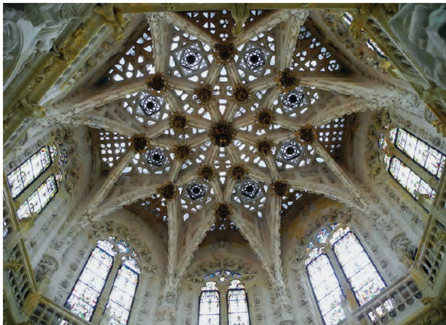
Fig. 150. Burgos. Catedral. Cimborrio. Detalle de la bóveda, en el que se aprecia que los nervios que conforman la estrella exterior, son, en realidad, arcos diafragma de tabiques calados que sostienen un cerramiento conformado por piezas planas, igualmente caladas. Foto: José Antonio Gárate.
