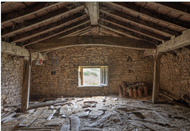
Fig. 76. Interior del pajar del invernadero de Praomontes con el bocarón al fondo. Se aprecia el funcionamiento de la estructura con las dos forasteras a los lados, el cumbril en el centro y la viga caballar en el centro con un enano dispuesto sobre ella para soportar el cumbril. (Autor, 2023)
