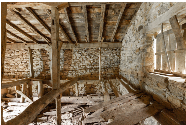
Fig. 115. Vista del interior del invernadero desde el muro divisorio. Se aprecia el correcto estado general de la estructura y la ausencia de viguetas y tableros que conforman el tillo del pajar. A la derecha, al fondo del invernadero, el bocarón a escasos centímetros de lo que sería el pajar. (Autor, 2023).
