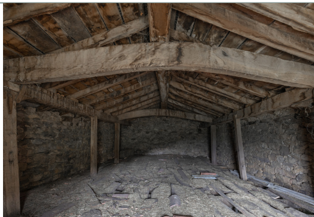
Fig. 77. Vista opuesta del interior del invernadero de Praomontes. De nuevo se aprecia la estructura completa de la cubierta y a los costados junto a la mampostería los huecos por donde se llenan los pesebres. (Autor, 2023)
