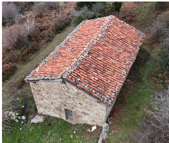
Fig. 44. Fotografía aérea de la cubierta de teja e hiladas de piedra de un invernadero. (Autor, 2024)
