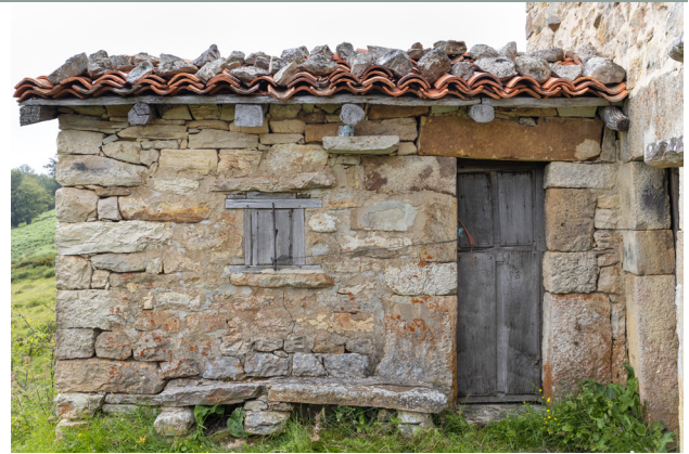
Fig. 110. Fotografía del chindorro junto al invernadero. En el lado derecho, la entrada al área del pastor, más estrecha que la del invernadero, y en el centro, el pequeño ventanuco practicado con posterioridad como se puede intuir por el rejunteo de la piedra. (Autor, 2023).
