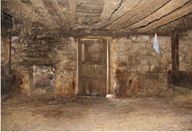
Fig. 97. Interior de la planta de cuadra del invernadero de La Mata. En el centro se dispone la entrada principal y a su izquierda se aprecia el atizadero junto a uno de los pesebres que flanquean la estructura. (Autor, 2023).
