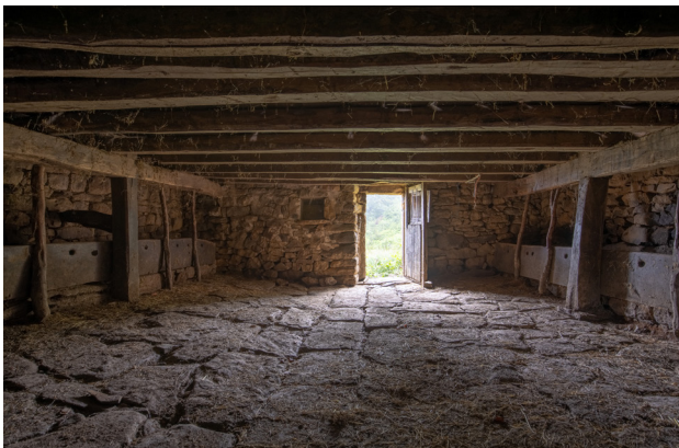
Fig. 78. Imagen de la planta de cuadra del invernadero con la entrada principal al fondo. Se aprecia la leve inclinación de las losas hacia el eje central y los pesebres a los costados. (Autor, 2023)
