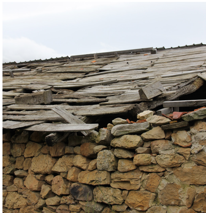
Fig. 49. Ejemplo de colocación de las ripias en un invernadero en ruinas. (Autor, 2023)
