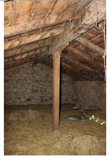
Fig. 94. Vista del interior del pajar donde se muestra el único pie derecho que soporta la cumbre situado en el centro del invernadero. (Autor, 2023).
