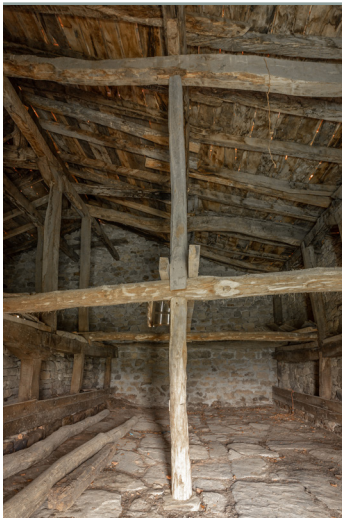
Fig. 112. Vista del entramado de madera que soporta la tercia en la cumbre y la viga horizontal a media altura que habría servido al forjado del pajar. (Autor, 2023).
