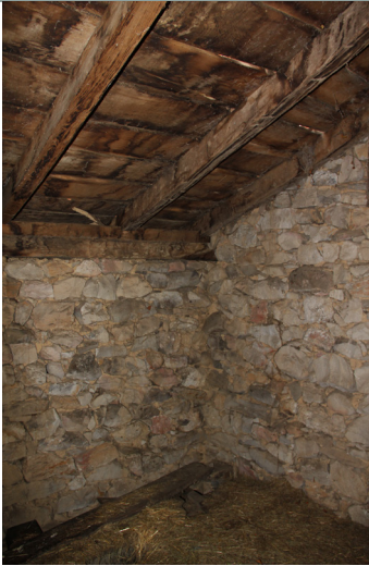
Fig. 92. Encuentro de la cubierta con el muro, donde la forastera se apoya en la mampostería dejando el espacio entre la viga y las ripias para ventilar. (Autor, 2023).
