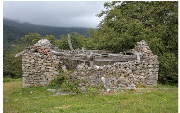
Fig. 46. Imagen de un invernadero con la estructura de madera completamente derruido pero con la mampostería aún en pie a excepción de parte de un lateral. (Autor, 2023)
