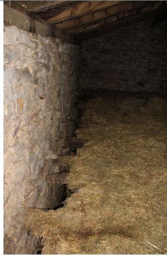
Fig. 93. Imagen del hueco de los cebaderos del pajar a través de los cuales se cargaba la paja en los pesebres situados justo debajo. (Autor, 2023).
