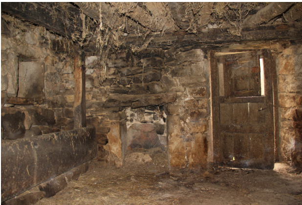
Fig. 99. Vista del área de estancia del pastor completa. A la izquierda del todo se encuentra la hendidura a modo de pequeño almacén de aperos, y a muy poca distancia, el atizadero junto a la entrada. (Autor, 2023).
