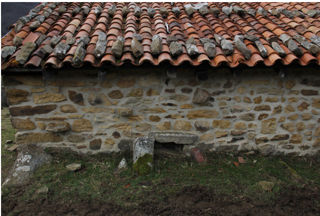
Fig. 74. Fachada noreste, donde el desnivel es mayor. Se observa una oquedad que responde a la función de extracción del humo del atizadero en el interior del invernadero. (Autor, 2023)
