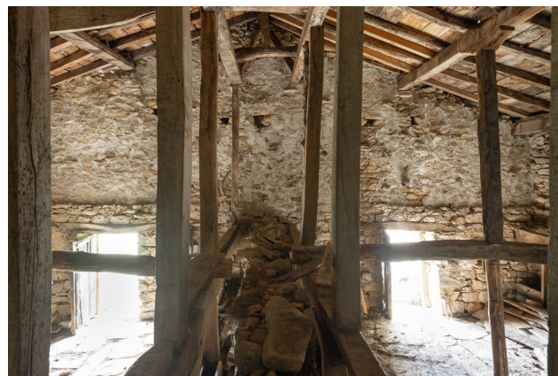
Fig. 116. Imagen del interior del invernadero desde el muro divisorio en la que se explica la doble estructura unida en altura para soportar el cumbrical. Al fondo de la imagen se aprecian las labores de mantenimiento y rehabilitación que ha sufrido esta construcción. (Autor, 2023).
