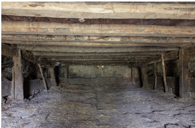
Fig. 79. Imagen tomada desde la entrada principal de la cuadra. Al fondo el pesebre en "entrevío" y a los costados en "vigá". Se aprecia la madera nueva de la rehabilitación de las viguetas. (Autor, 2023)
