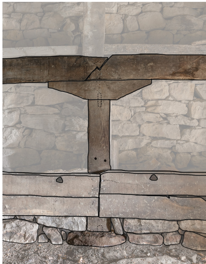
Fig. 47. Imagen de la estructura de madera apoyada sobre la piedra y con los espigos marcados. Elaboración propia.
