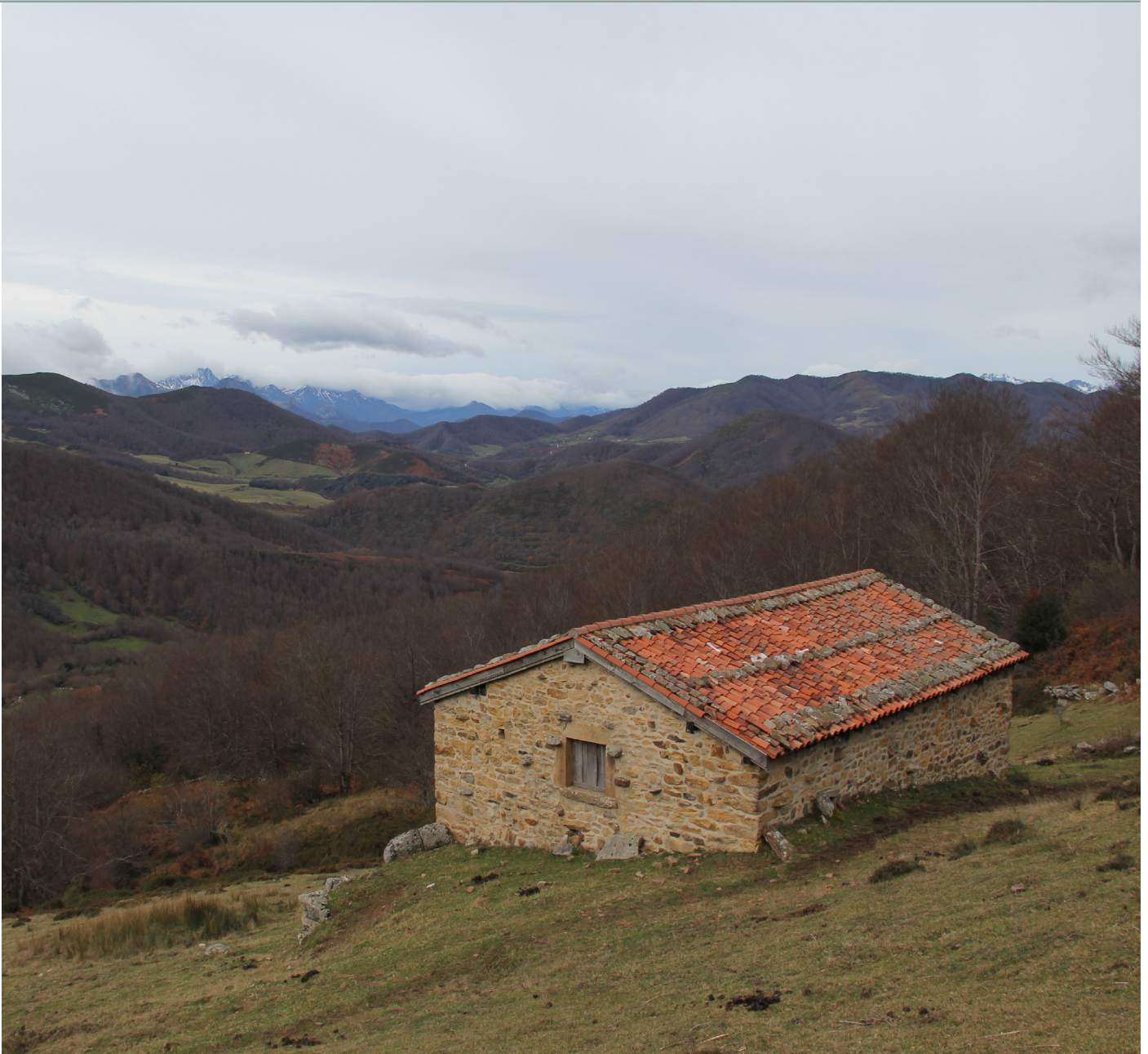
Fig. 80. Fotografía del invernadero de Praomontes y sus vistas al Valle de Polaciones. Se aprecia con facilidad el desnivel sobre el que se erige la edificación. Elaboración propia, verano 2023.
