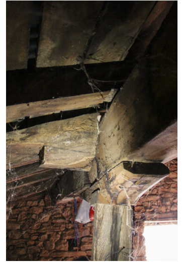
Fig. 73. Detalle del recibimiento de una forastera al cabrio. Por debajo se dispone la zapata y el pie derecho sobre el que apoya la estructura. (Autor, 2023)
