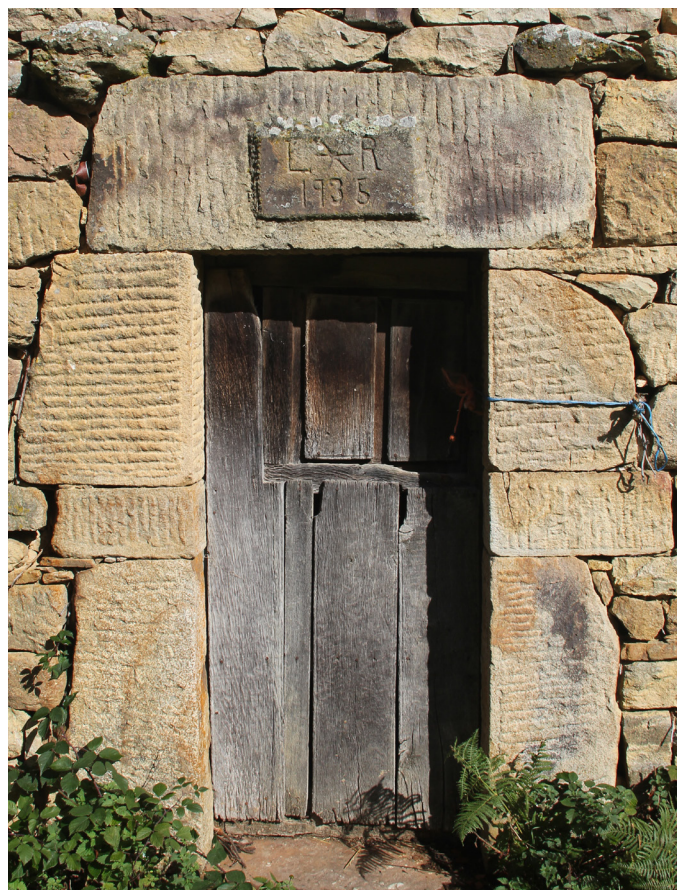
Fig. 25. Puerta de acceso al invernal con sillería y grabados en el dintel. (Autor, 2024)
