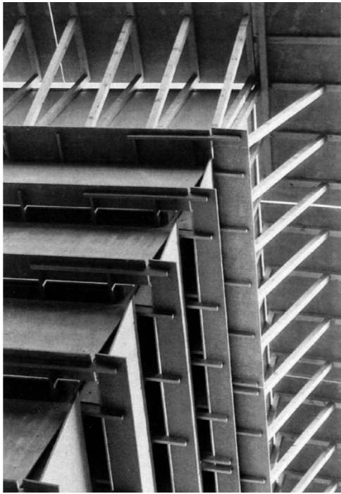
Fig.29: Se observa en esta imagen la estructura de madera que soporta los paneles de fibrocemento. Dichos paneles se disponen en forma de L. En la cornisa, la subestructura de madera se desvela para marcar un ritmo vertical y crear la imagen de cornisa, en paralelo con el ritmo creado en el zócalo. La construcción marca la forma y el ritmo.
