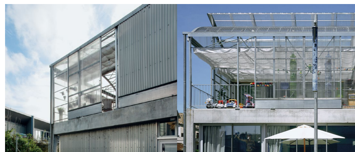
Fig. 30: Fotografías de la envolvente exterior. Sistemas opacos y translúcidos. Sistemas móviles y fijos.
