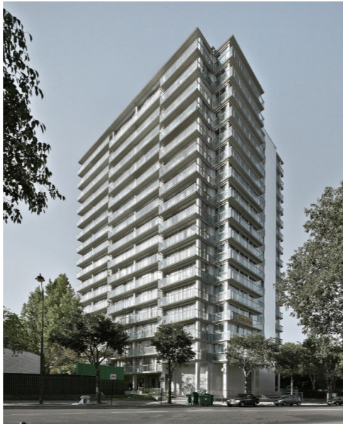
Fig. 34: Fotografías exteriores de la nueva envolvente de la Torre Bois-le-Prêtre. Lacaton y Vassal. La sistematización del jardín de invierno.
