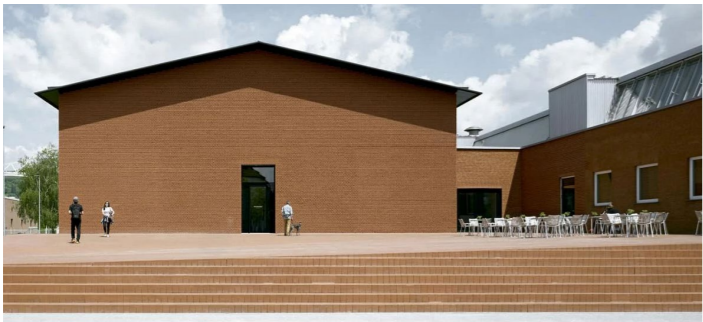
Fig.44: El nuevo almacén de Vitra mantiene la forma de la casa arquetípica con cubierta a dos aguas y planta rectangular. La fachada es totalmente opaca.
