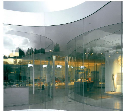
Fig.20: Pilar estructural esbelto e independizado del cerramiento. Triple piel de cristal incoloro curvado con patios de luz y reflejos externos.
