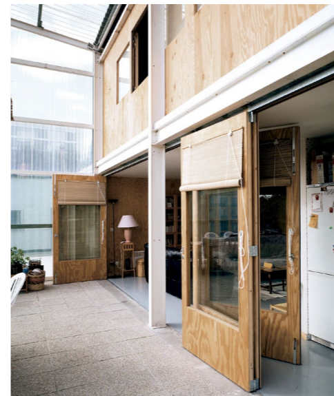
Fig. 16: La caja de madera aislada se encaja en la estructura metálica. El invernadero se convierte en un espacio contiguo adosado.
