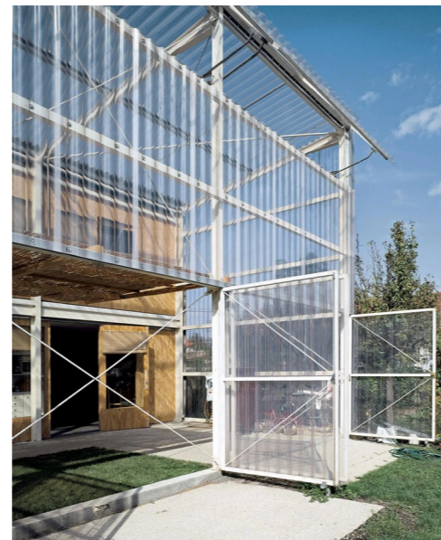
Fig. 5: La envolvente de la Casa Latapie inspirada en los invernaderos agrícolas, presenta un dinámico sistema de apertura de los planos del cerramiento que transforma el espacio y se adapta a las necesidades.
