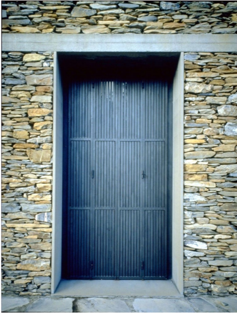
Fig.31 y 32: La estructura de hormigón se extiende hacia el exterior formando el pórtico y marcando su independencia. Los huecos marcan la profundidad del cerramiento de piedra.
