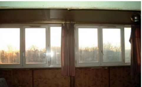
Fig. 36: Sistema de reemplazo de la envolvente preexistente con una nueva doble piel. El invernadero adosado.
