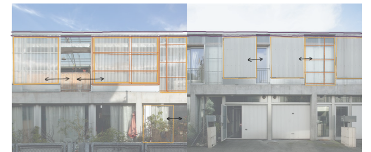
Fig. 33: Fotografías de la envolvente exterior. Sistemas opacos y translúcidos. Sistemas móviles y fijos.
