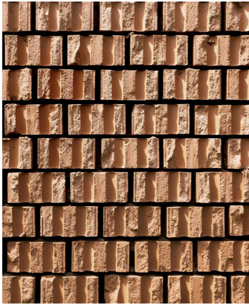
Fig.46 y 47: Cada ladrillo partido de forma artesanal da lugar a una fachada vibrante, con dimensión y profundidad. Las juntas entre ladrillos se realizan con un notable espesor para aportar más profundidad.
