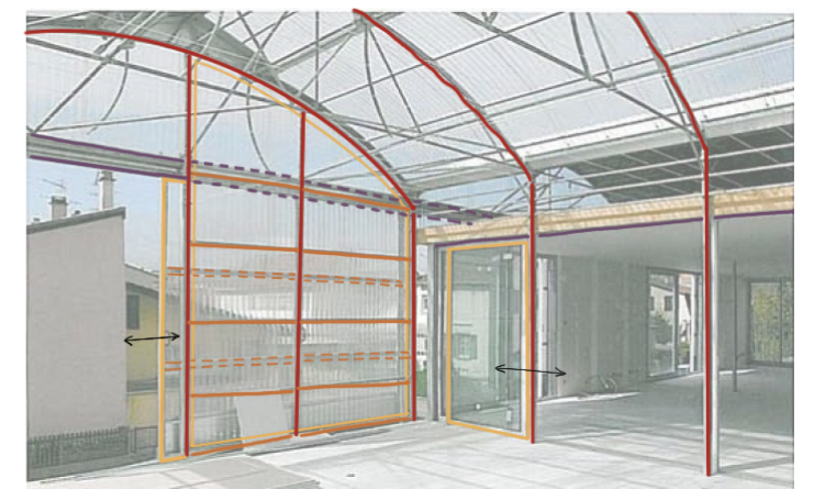
Fig. 32: Fotografía de obra. Sistema de railes y perfiles metálicos para el movimiento de la envolvente de policarbonato. El espacio aislado encajado en la estructura general del invernadero.
