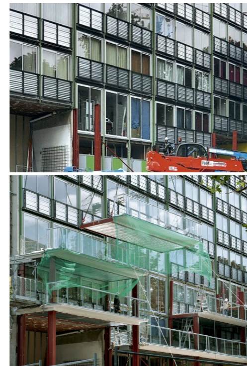
Fig.40: Fotografía del proceso de construcción de la nueva envolvente. Se reemplaza por las nuevas carpinterías y se apilan los módulos prefabricados con sus respectivos soportes verticales.
