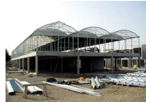
Fig. 25: Fotografía de obra. Zócalo de hormigón y estructura metálica anclada en la parte superior.
