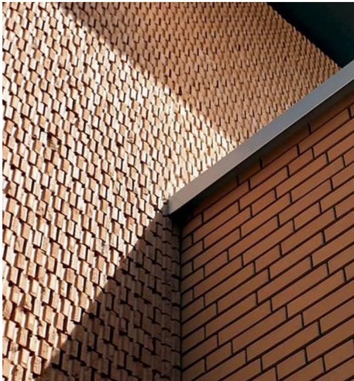
Fig.46: Encuentro entre el ladrillo dispuesto de forma tradicional y el ladrillo partido que compone la envolvente del almacén de Herzog y de Meuron.
