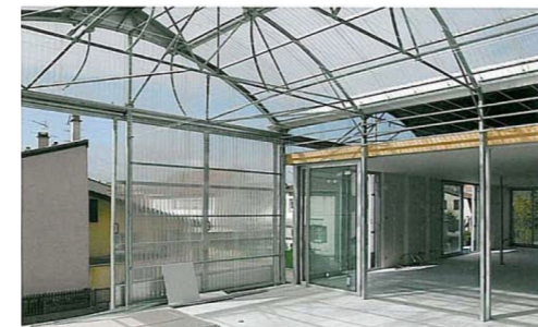
Fig.50: Un sistema directo realizado mediante una técnica de anclaje por atornillamiento en seco.
