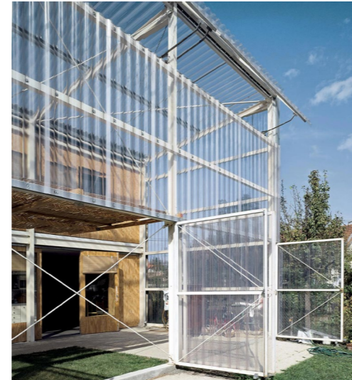
Fig.49: Un sistema transformable compuesto de polycarbonato ondulado translúcido y perfiles metálicos.
