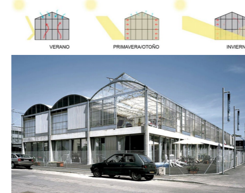
Fig. 12: Ciudad Manifiesto en Mulhouse. Un espacio construido con policarbonato ondulado de diferentes opacidades y soluciones constructivas directas y sencillas.
