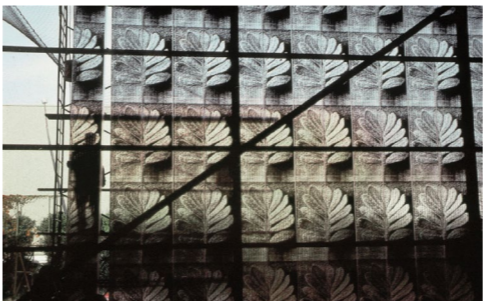
Fig.5 y 6: Almacén Ricola-Europe SA en Mulhouse. Los paneles serigrafiados crean una innovadora envolvente que expresa su contenido interior con la imagen de la hoja de Ricola.
