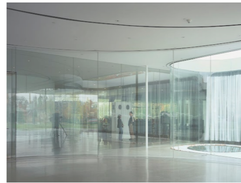
Fig.20: Pilar estructural esbelto e independizado del cerramiento. Triple piel de cristal incoloro curvado con patios de luz y reflejos externos.
