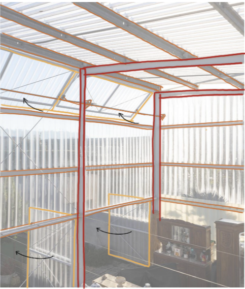
Fig. 18: Mecanismos de apertura del jardín de invierno. Un sistema sencillo de cables, perfiles y tirantes metálicos con láminas de policarbonato transparente.
