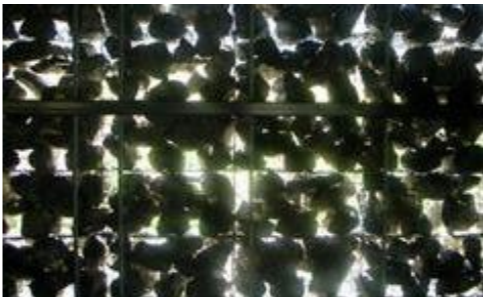
Fig.2,3 y 4: Fachada de las bodegas Dominus. La piel del edificio se realiza con una envolvente petrea que innova por su uso de gaviones dotando a la piedra de permeabilidad.
