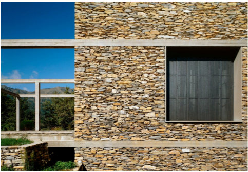
Fig.33 y 34: La cruz de hormigón que domina sobre el cerramiento de piedra.
