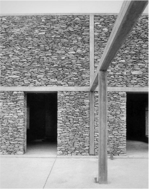
Fig.35 y 36: La estructura de hormigón aparece y desaparece en puntos clave. La viga sirve como dintel para los huecos.
