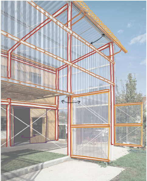
Fig. 20: La envolvente del invernadero se abre de forma casi completa mediante distintos sistemas batientes.
