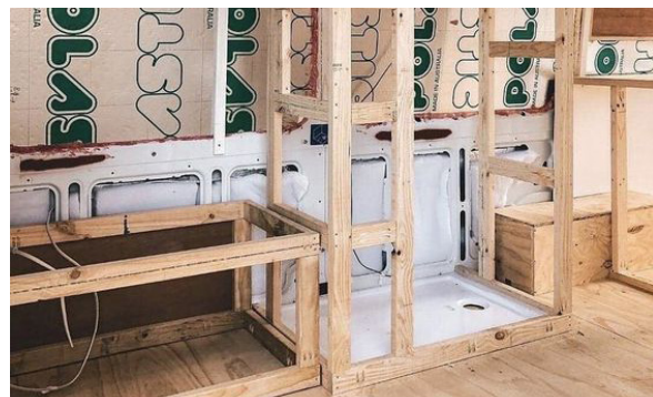
Imagen 415: Rastreles de madera para estructura general de muebles. (Fuente: Pinterest)
