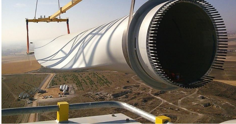
Ilustración 15: Instalación de una pala. Fuente: [9]
