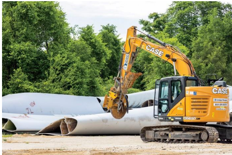
Ilustración 23: Corte de palas de aerogenerador mediante disco de corte. Fuente: [23]
