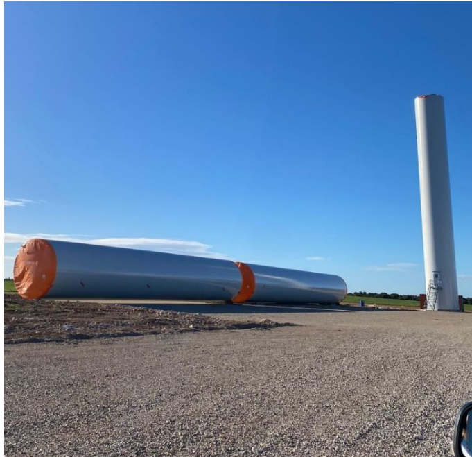
Ilustración 12: Almacenaje de módulos de la torre previo al montaje. Fuente: elaboración propia
