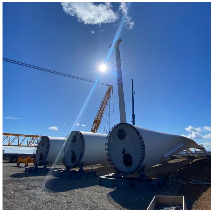
Ilustración 16: Almacenaje de las palas en la plataforma de montaje. Fuente: Elaboración propia.
