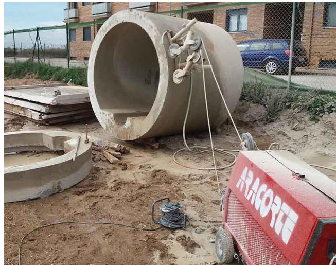
Ilustración 34: Equipo de corte con hilo adiamantado. Fuente:[37]
