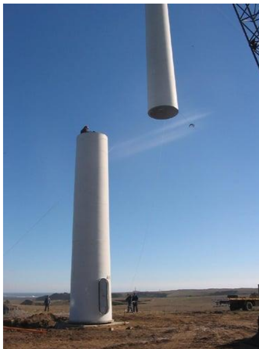
Ilustración 13: Montaje modular de una torre eólica de acero. Fuente: [6]
