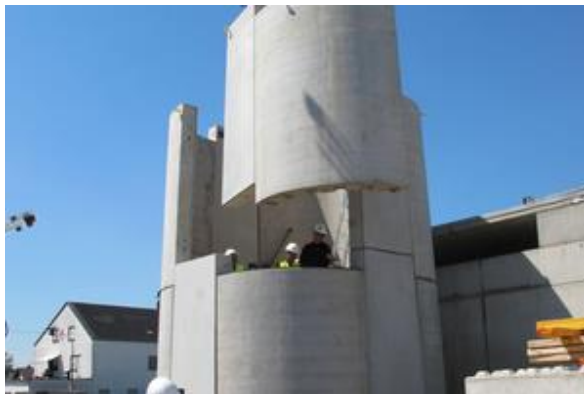
Ilustración 28: Torre de hormigón segmentada. Fuente:[31].
