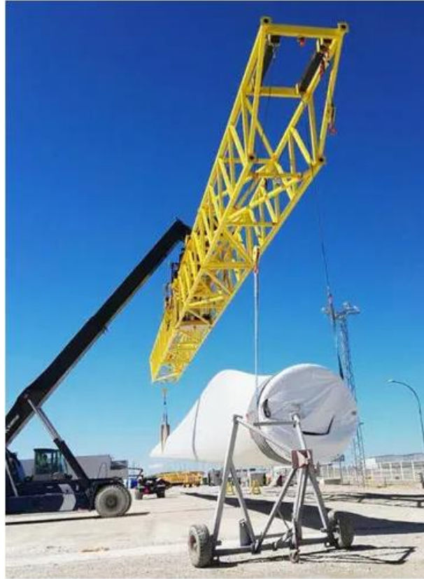
Ilustración 21: Utillaje de elevación de palas. Fuente: [13]
