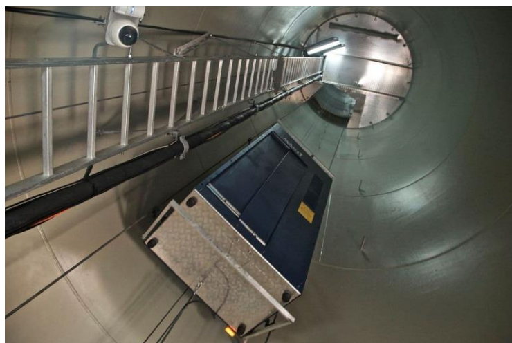
Ilustración 27: Interior de torre aerogenerador: sistema de elevación por cable. Fuente: [17]
