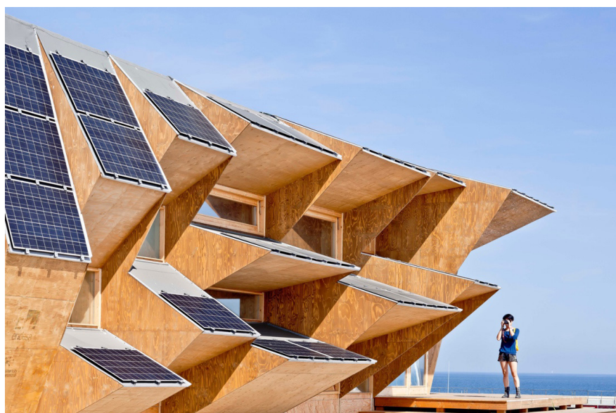
Imagen 27. Paneles fotovoltaicos en distintos ángulos. Fuente: https://www.archdaily.cl/cl/627994/pabellon-endesa-margen-lab
