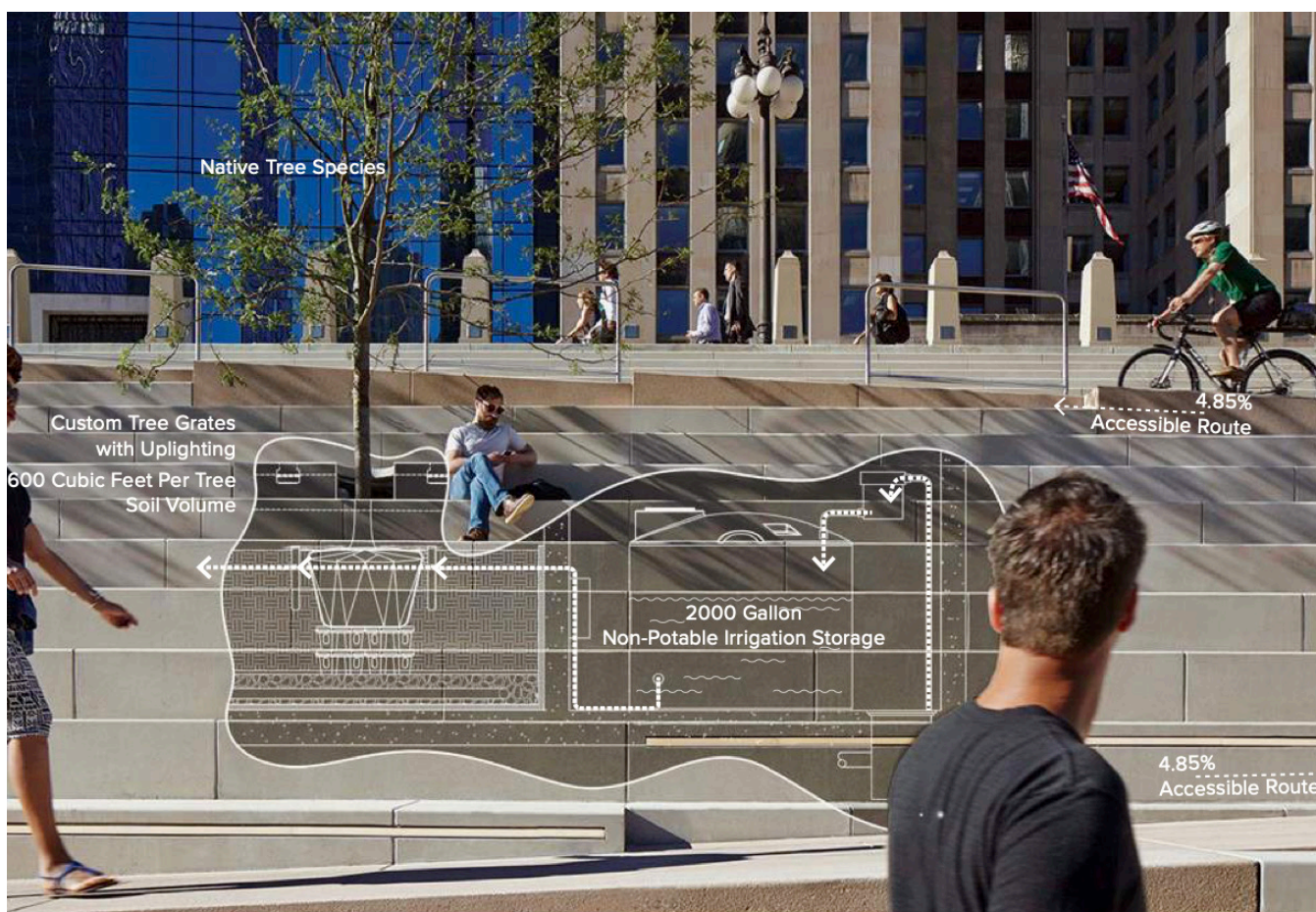
Figura 4.1.11. Sistema de recuperación de aguas fluviales en The River Theatre.
