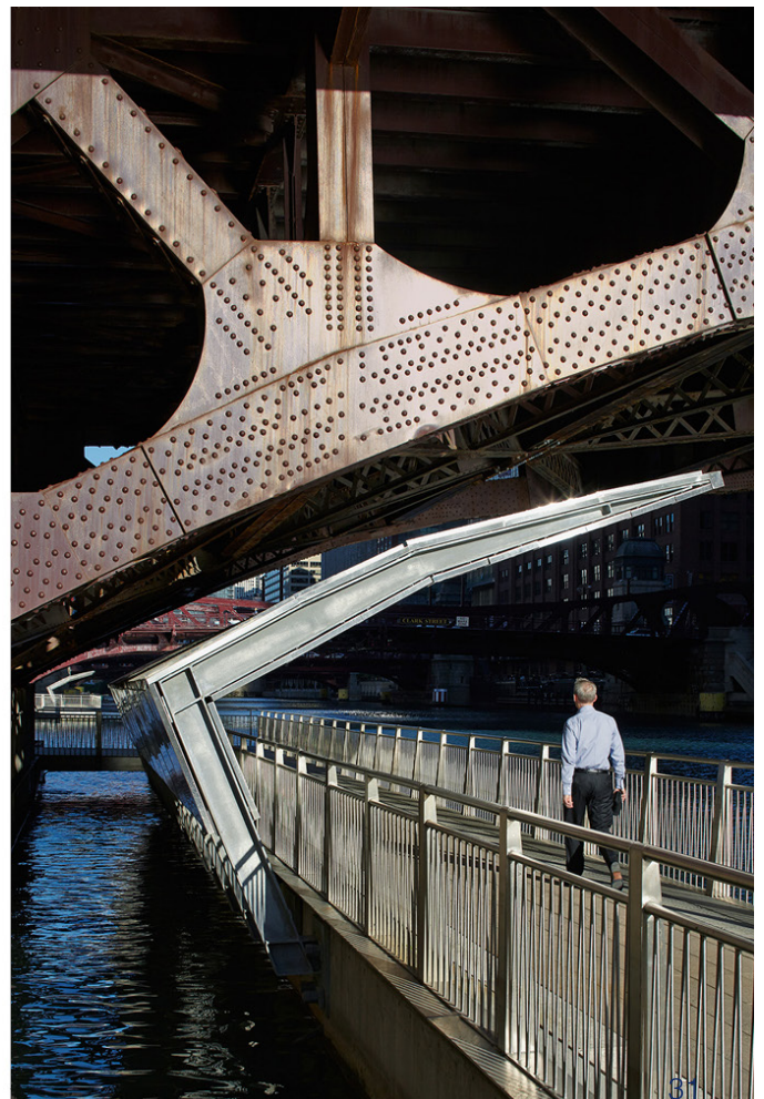
Figura 2.12. Las conexiones bajo el puente proporcionan un camino continuo a nivel del río y protección para los peatones.
