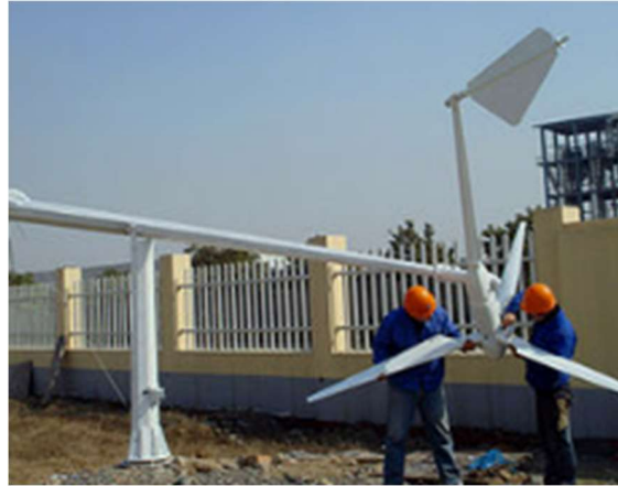
Fig. 21. Torres eólicas basculantes. (Conceptos básicos sobre torres eólicas, s.f.-a)
