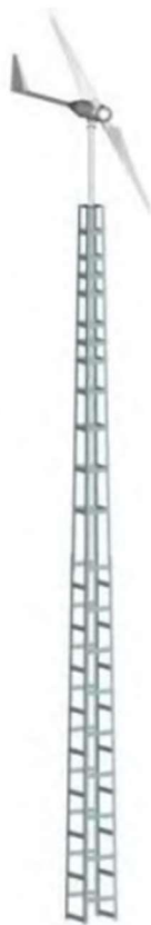
Fig. 8 Torre de celosía (Eco fener)
