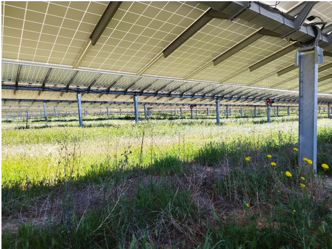
Figura A2. Zona continuamente sombreada del área con placas fotovoltaicas dentro del PSF. Se observa a su vez el eje de rotación sobre el cual giran los paneles fotovoltaicos a lo largo del día para recibir la máxima cantidad de radiación posible.
