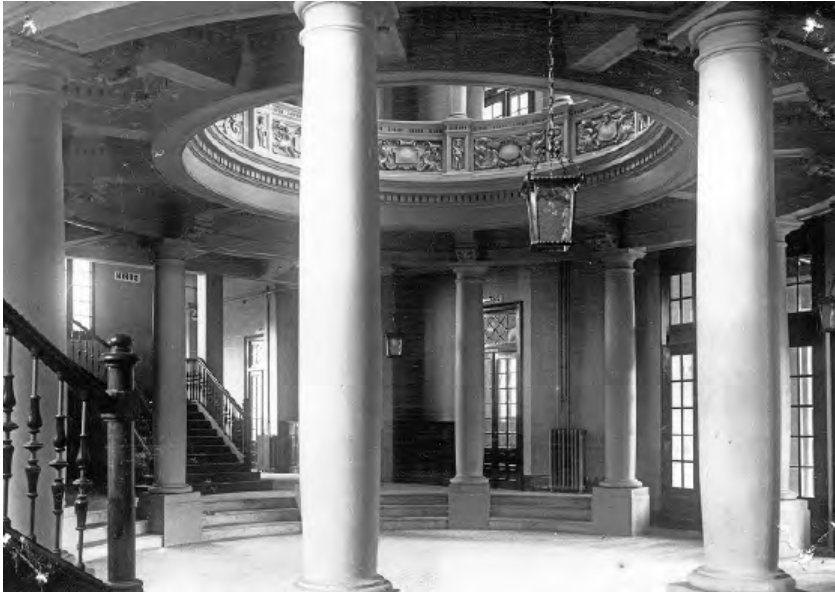
Fig. 5. Vestíbulo, planta baja, con la rotonda y escalera del grupo escolar Joaquín Costa. Fotografía: Marín Chivite, 1929 (A.M.Z.).
