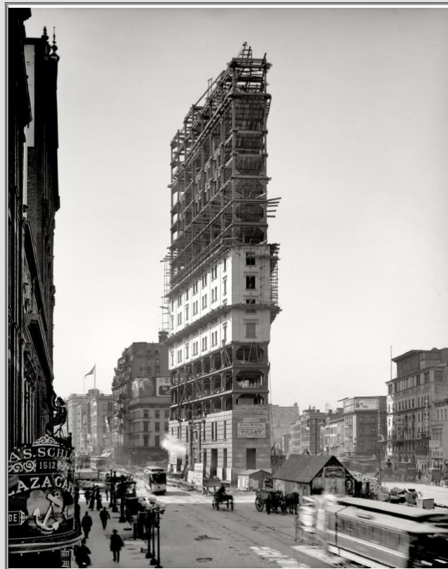
Fig. 1. Año 1903. Edificio One Times Building en construcción. Autor: Desconocido.
