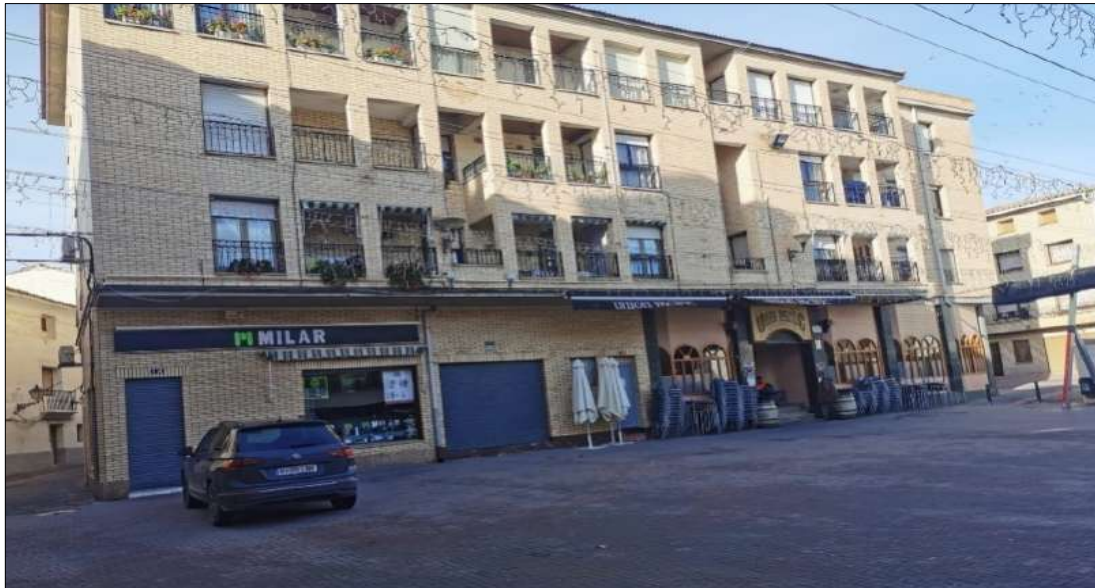
Fig. 19. Bloque de pisos levantado tras el derribo de la antigua casa consistorial de Valtierra y el edificio colindante.
