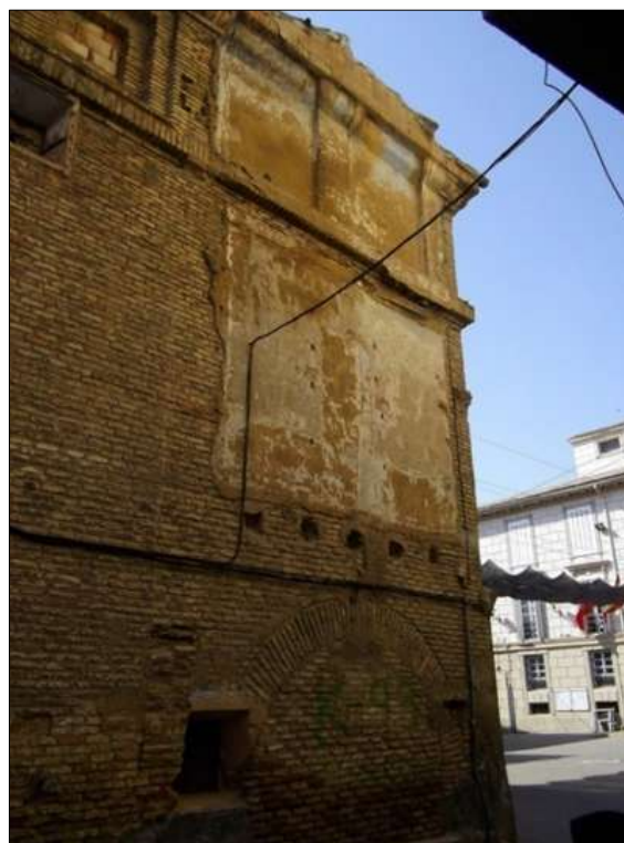
Fig. 15. Huella de la sala de sesiones de la casa consistorial tras su derribo. 2017. Fotografía: Carmen Jiménez.
