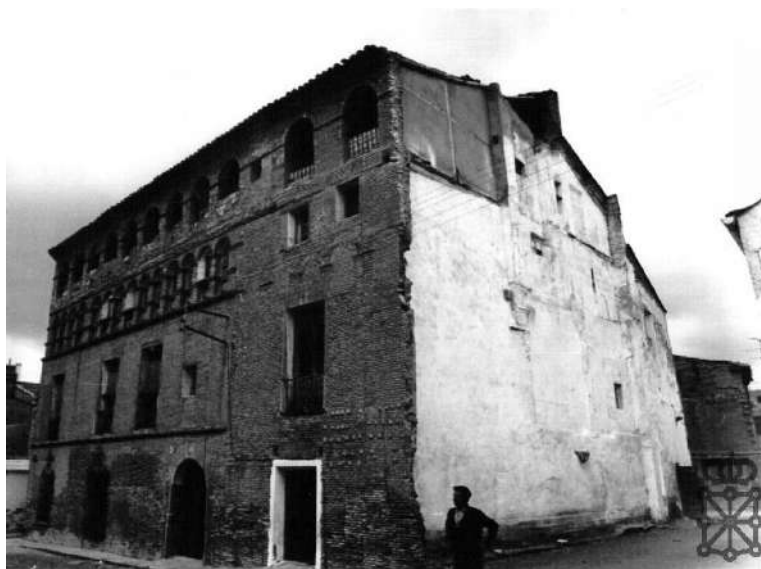
Fig. 108. Casa Ríos tras el derribo de la parte declarada en ruinas. AGN
