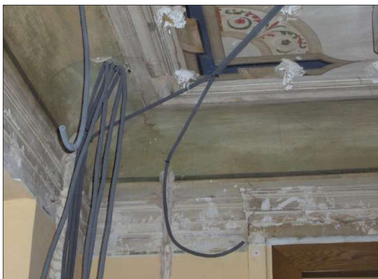
Fig. 93 Actuaciones para acondicionar una de las estancias de la casa de La Peña en Valtierra para ser usado como sala de juntas municipal. Fotografía: Matilde Jiménez.
