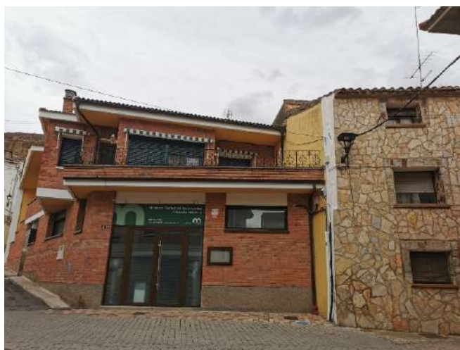
Fig. 62. Edificios levantados en el lugar donde estaba emplazada la casa principal de los Atondo en la calle Mayor de Valtierra. Fotografía: Carmen Jiménez.
