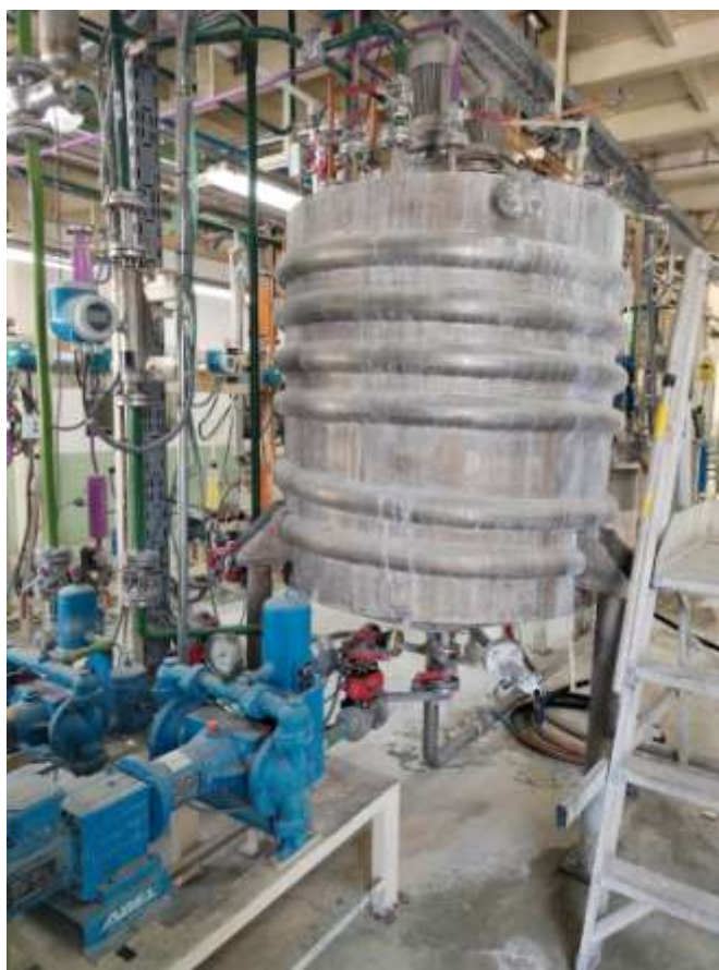
Figura 6.- Fotografía del tanque de reacción de la instalación piloto.
