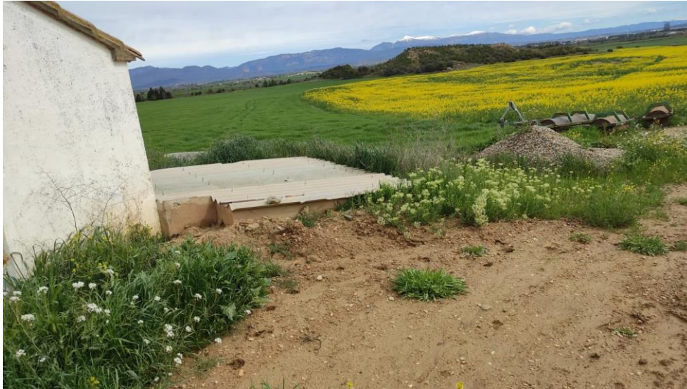
Figura 2.2 Caseta y campo de regadío
