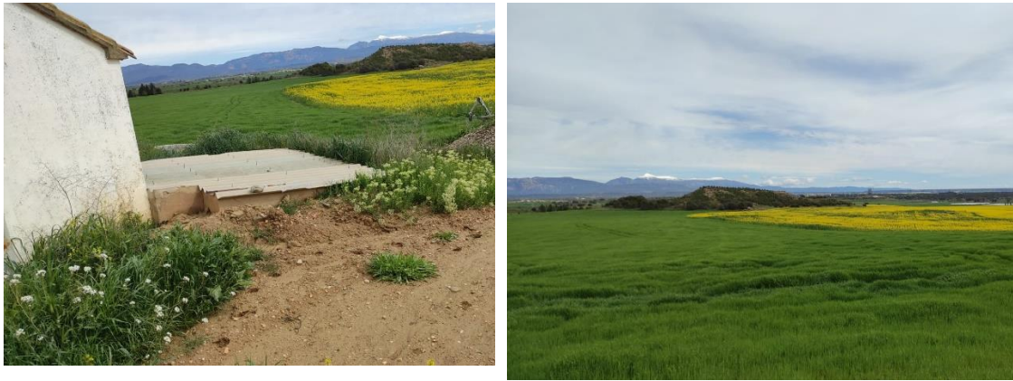
Figura I. 4 Caseta donde se ubica el codo en Y y la bomba de 33kW (izquierda) y campo de regadío con colza
