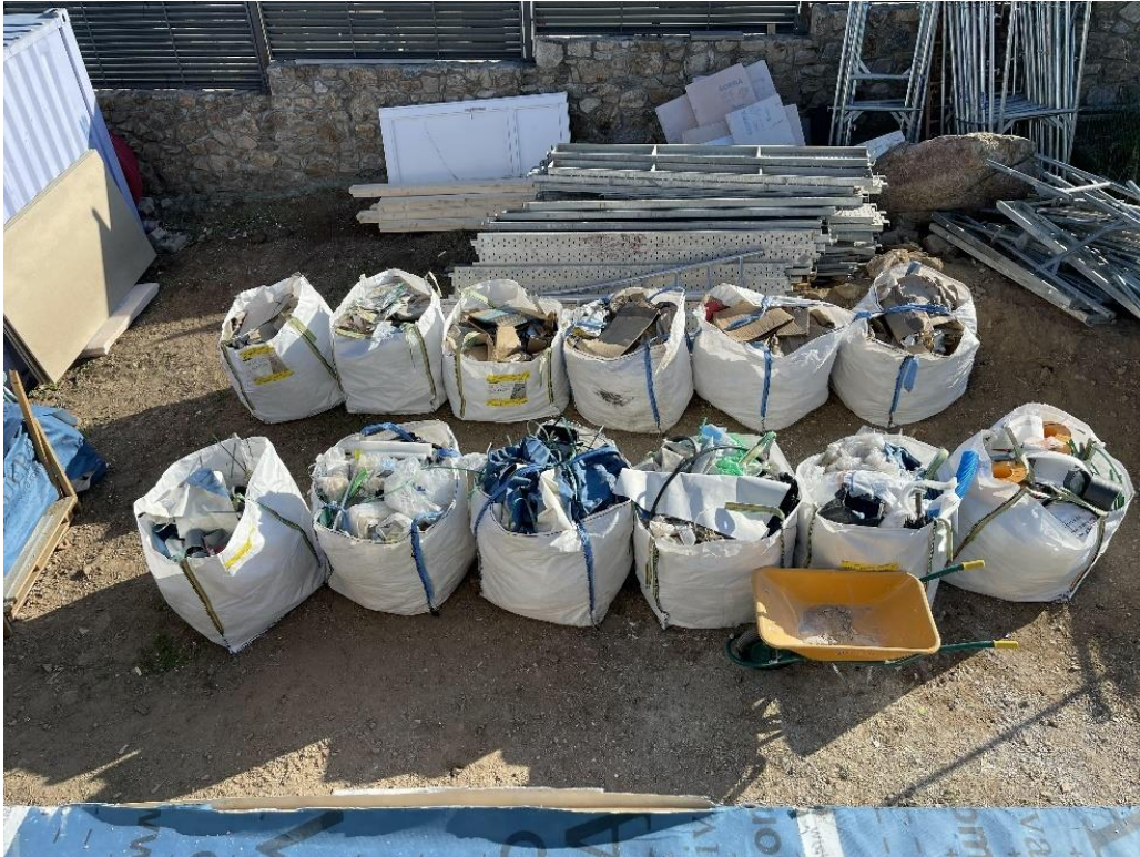
Ilustración 22 Punto limpio estándar en una obra a base de Big Bags (Circular, 2023).
