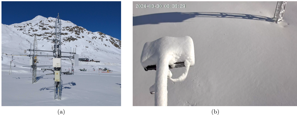
Figura 18: (a) Prototipo instalado en la estación experimental AEMET-Formigal, junto con el radar SFCW desarrollado por el GTF. (b) Condiciones habituales de operación del prototipo que justifican la importancia de la estanqueidad del radomo.
