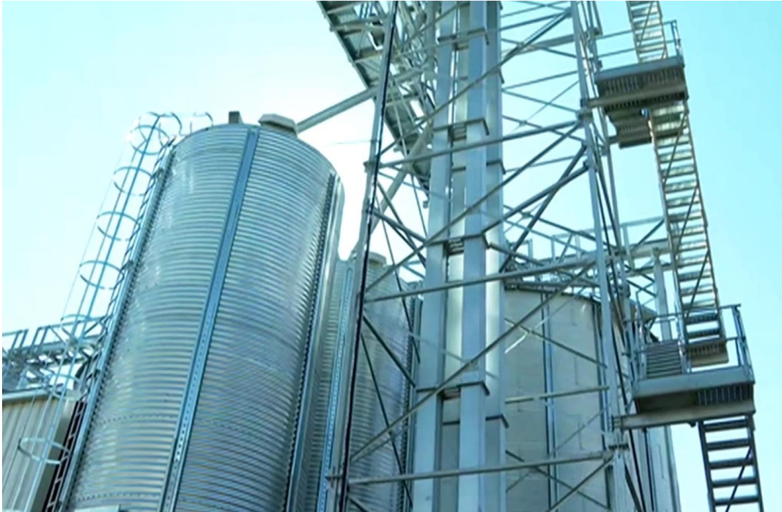
Figura 80. Instalaciones y silos de almacenaje de la agroindustria (CartaTV, 2021).
