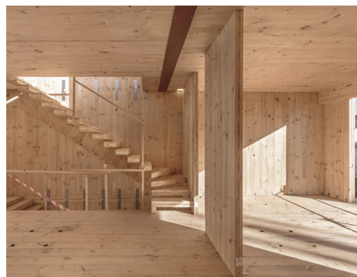
Fig. 39. Edificio de estructura de CLT en su totalidad.
