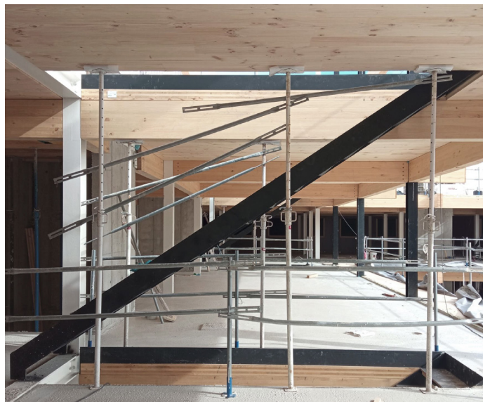
Fig. 84. Escalera metálica. Suelo de CLT + hormigón para acústica.
