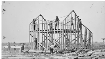
Fig. 21. Construcción vivienda Balloon Frame.
