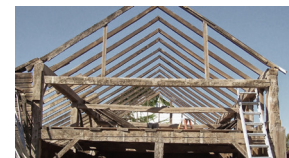
Fig. 8. Estructura Balloon Frame.
