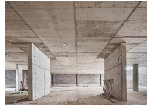
Fig. 62. Vista sótano en construcción.
