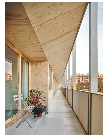
Fig. 53. Vista exterior pasillo.
