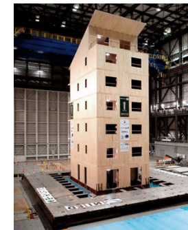
Fig. 29. Edificio para la prueba de resistencia a sismos.
