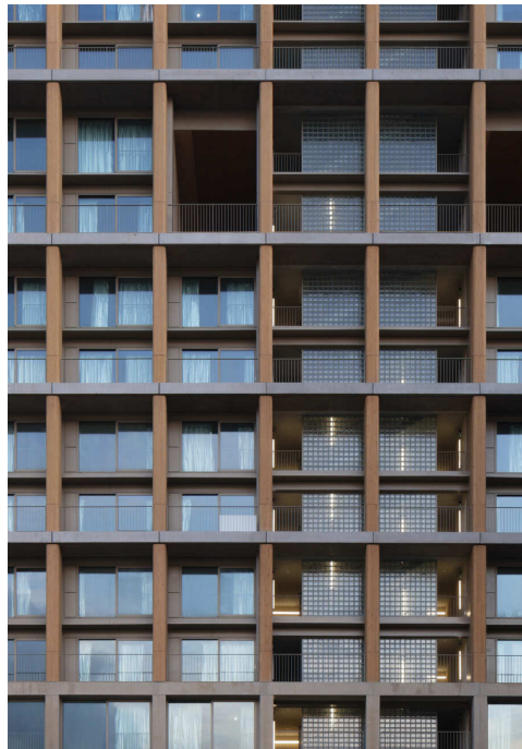
Fig. 102. Vista exterior. Columnas y vigas que sujetan el cristal en su sitio.
