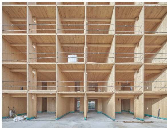
Fig. 51. Vista exterior en fase de construcción.
