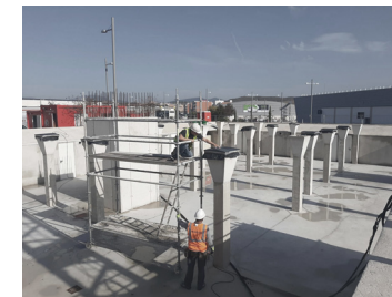
Fig. 74. Pilares hormigón planta sótano.
