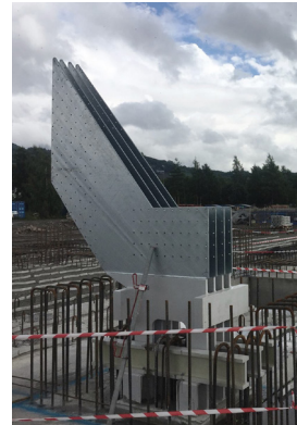
Fig. 116. Detalle constructivo. Unión acero. Encofrado a cimentación.
