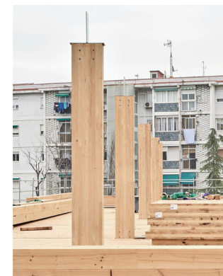
Fig. 64. Pilar Glulam con unión metálica.
