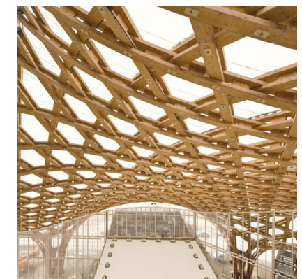
Fig. 41. Centre Pompidou, Metz, Francia, Shigeru Ban, 2010.
