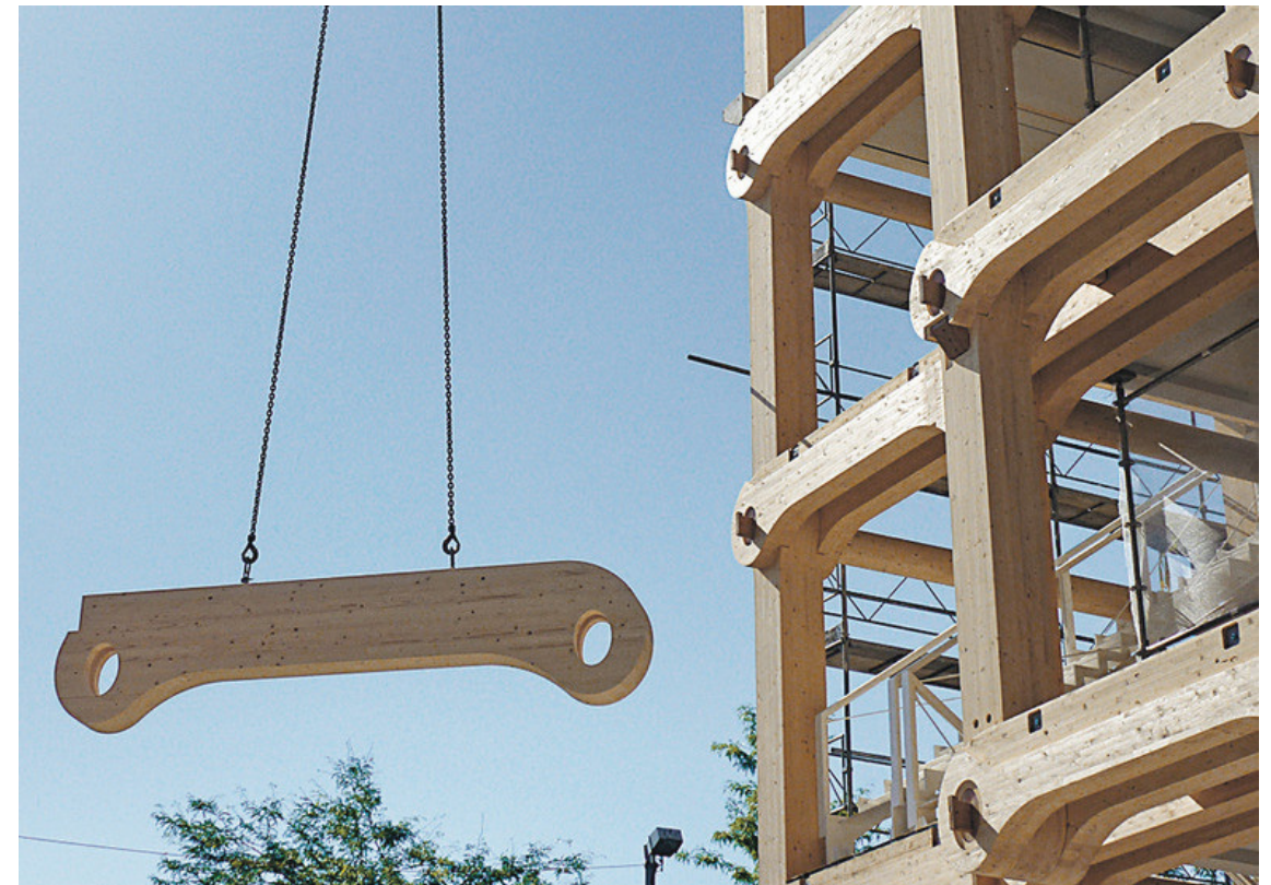
Fig. 27. Montaje vigas de las oficinas Tamedia, Zurich, Shigeru Ban.
