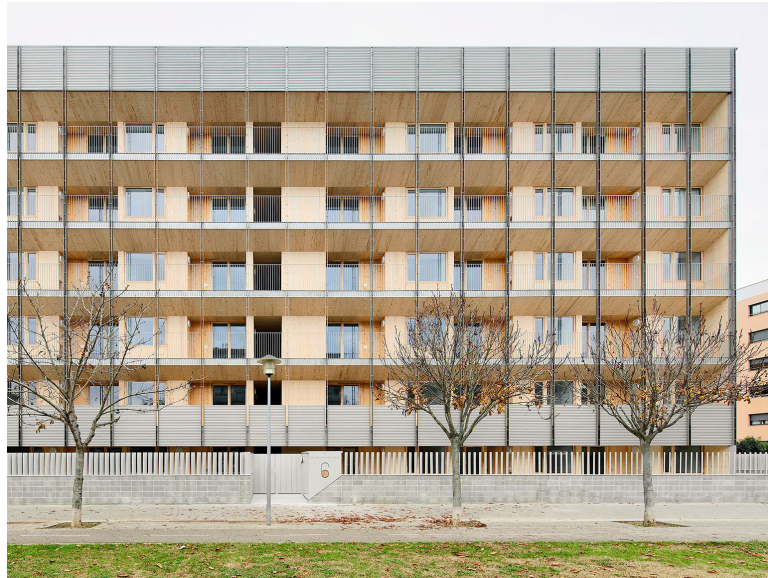
Fig. 45. Fachada norte Bloque 6x6.
