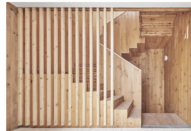
Fig. 56. Núcleo de escaleras íntegro en CLT.
