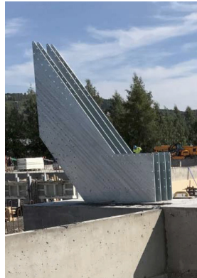
Fig. 114. Detalle constructivo. Unión acero. Cimentación - Viga.
