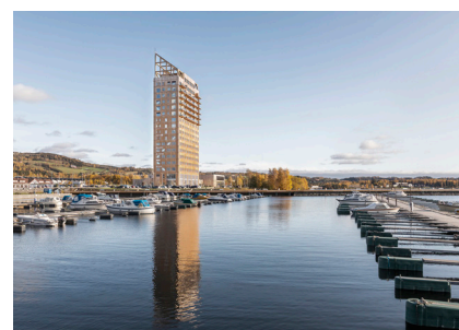
Fig. 26. Torre Mjøstårnet, Noruega, Voil Arkitekter, 2019.
