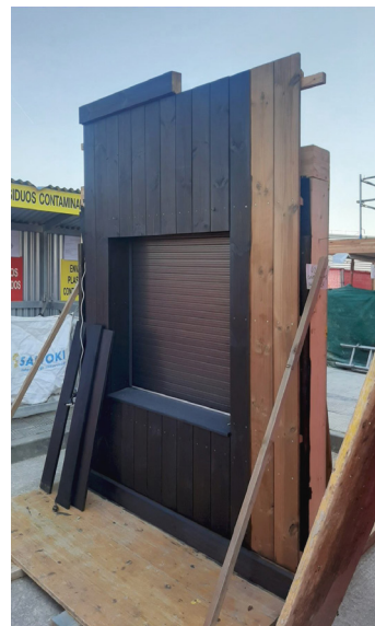
Fig. 85. Foto fachada prefabricada.
