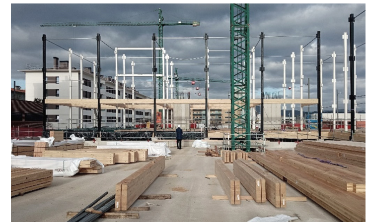
Fig. 83. Foto de obra. Vigas espando a ser colocadas.
