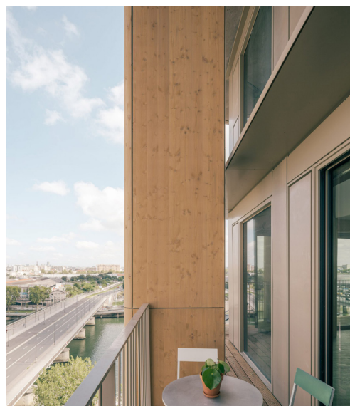
Fig. 98. Vista exterior. Correspondencia con detalle.
