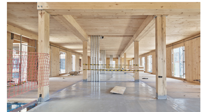
Fig. 65. Vista interior en obra con instalaciones. Estructura unidireccional.
