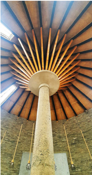
Fig. 136. Vista interior formación de la cubierta del proyecto
