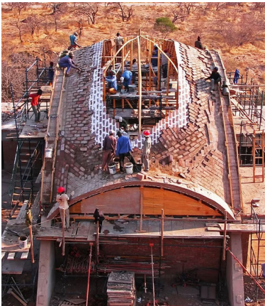
Fig. 28. Vista panorámica de la colocación de las 3 capas de ladrillos BTC
