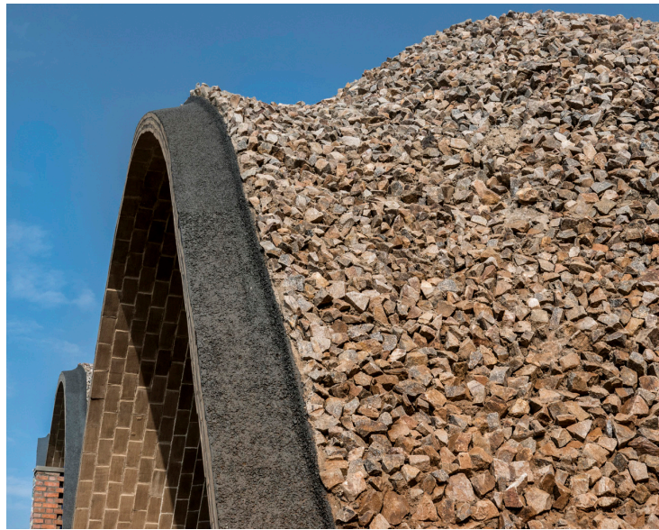
Fig. 56. Detalle del recubrimiento de la envolvente con la piedra local
