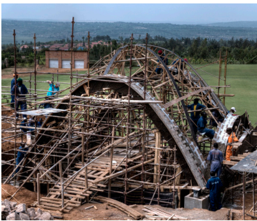
Fig. 50. Proceso de construcción de una de las bóvedas colocando la primera capa de ladrillos y la geomalla
