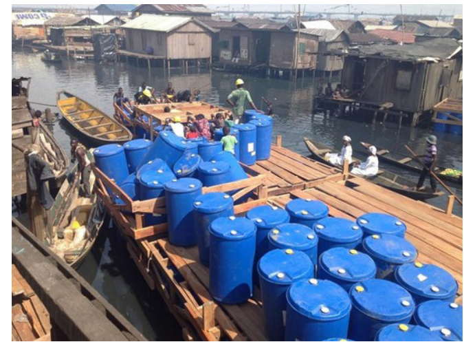
Fig. 126. Barriles de plástico llenos de agua para la flotabilidad. Makoko Floating School
