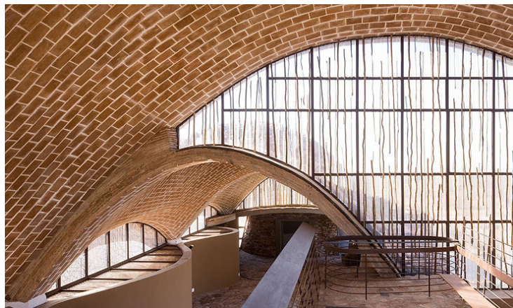
Fig. 36. Cara interior de la fachada norte con las lamas de acero cortén
