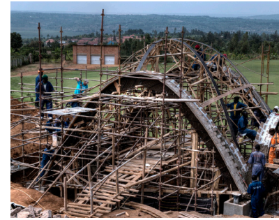
Fig. 213. Construcción de la bóveda del cricket stadium
