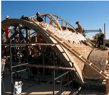
Fig. 11. Fotografía tomada en Limpopo durante la construcción de la bóveda del Mapungubwe Interpretation Center
