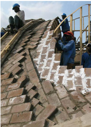
Fig. 29. Zoom mostrando las 3 capas de ladrillos BTC que se van colocando en ángulos.
