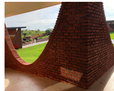
Fig. 124. Detalle de la unión de dos arcos en esquina
