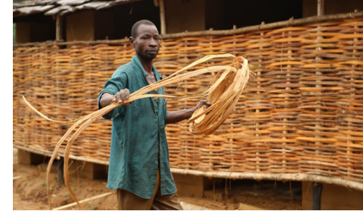
Fig. 216 y 217. Utilización de materiales vegetales para las puertas y paredes de Ilima Primary School
