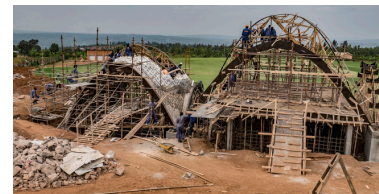
Fig. 60. Proceso de construcción de 2 de las 3 bóvedas
