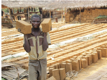
Fig. 13. Ladrillos de adobe untados en aceite de palma. Fotografía tomada en Ilima durante la construcción del Ilima Primary School.
