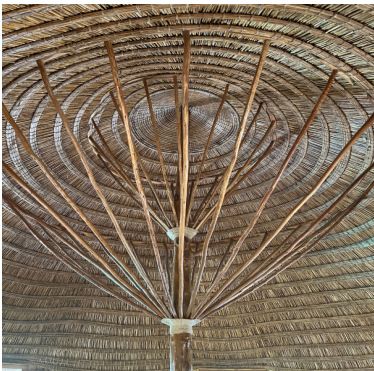
Fig. 132. Vista interior formación de la cubierta de un tukul tradicional
