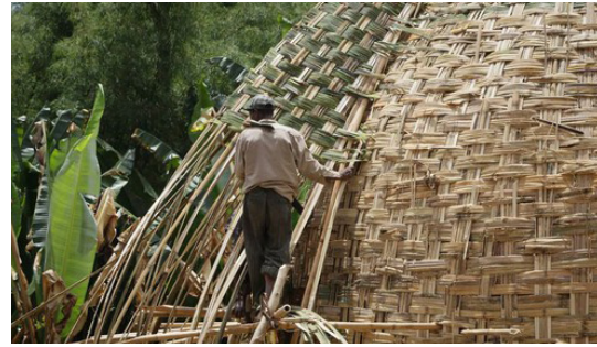
Fig. 204. Trenzado de caña para el cerramiento de una cabaña Dorze
