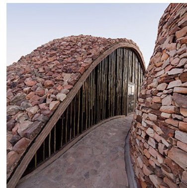
Fig. 39. Bóvedas revestidas con la piedra local y las lamas de acero cortén para la protección solar
