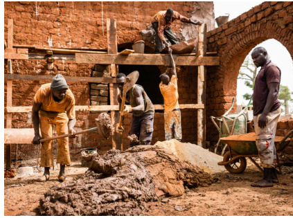
Fig. 203. Elaboración de arcilla y mortero en obra
