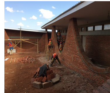
Fig. 123. Proceso de construcción de los arcos
