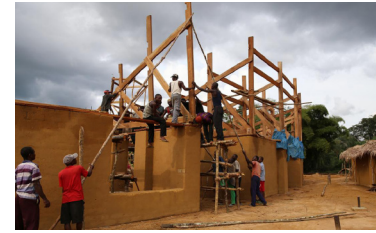
Fig. 76. Proceso de construcción de la cubierta
