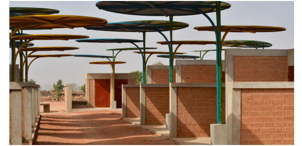
Fig. 220. Protecciones solares con forma de árbol en el mercado de Dandaji
