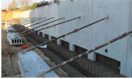
Figura V.2: Muro macizo prefabricado
