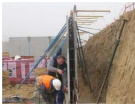
Figura V.1: Muro doble prefabricado
