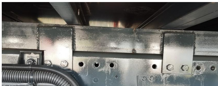
Ilustración 6 – Fijación de la estructura del chasis mediante placas atornilladas
