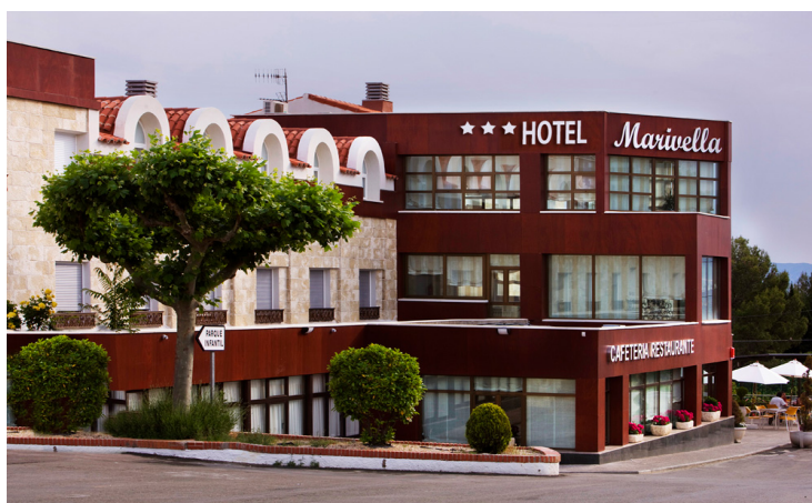
Imagen 2.1.2: Fotografía del Hotel actualmente
