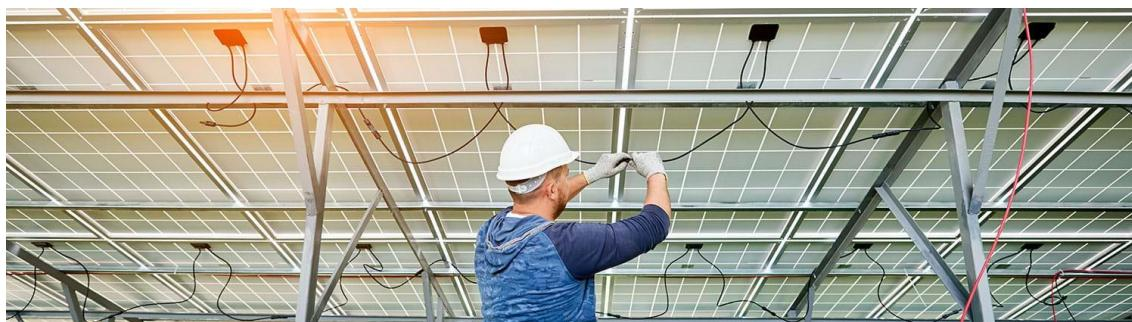
Figura 175: Cableado de una instalación fotovoltaica.
