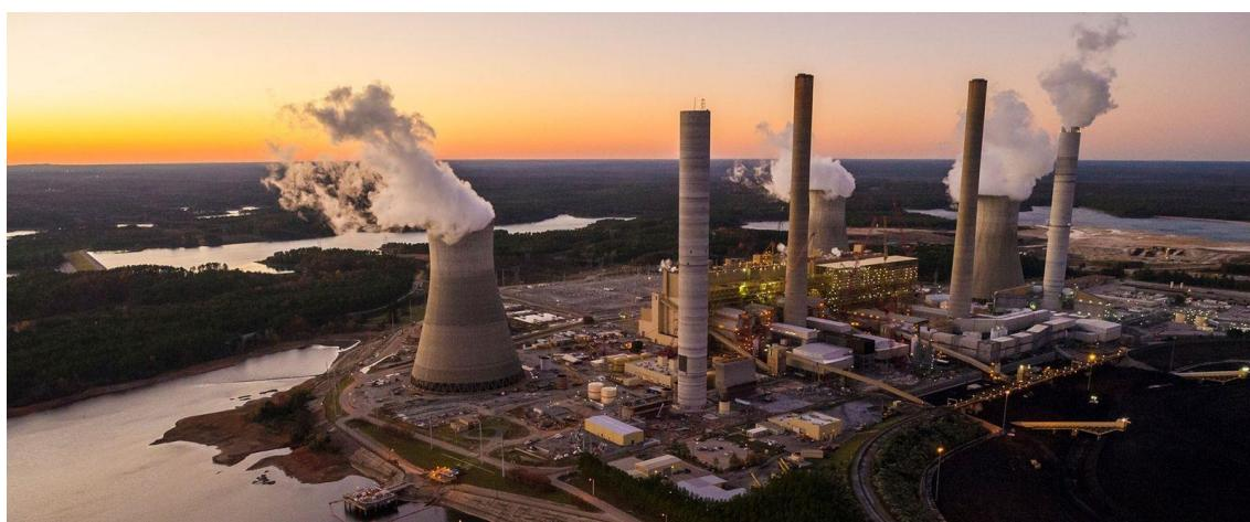
Figura 2: Torres de refrigeración y chimeneas de una central eléctrica.
