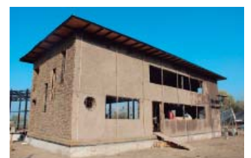
FIG71. Aspecto final de un proyecto realizado con técnicas mixtas Acero-Tierra. ECoT (Escuela de Construcción en Tierra).
