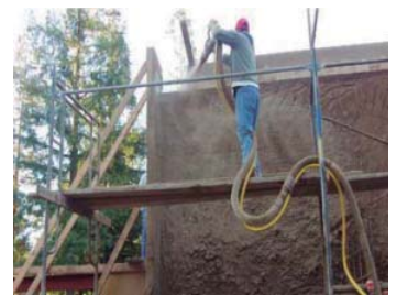
FIG45. Proyectado de la tierra sobre encofrado. PISE.
