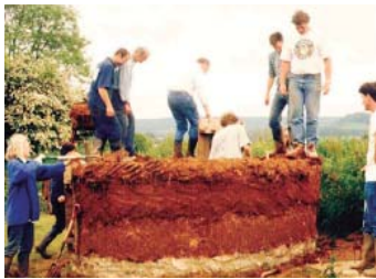
FIG49. Proceso construcción COB.
