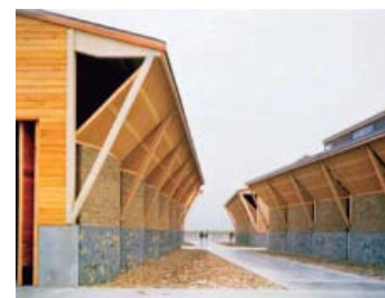
FIG34. Muros de adobe protegidos por los aleros de la cubierta y los zócalos de hormigón y piedra. Bodega Los Robles, San Fernando, Chile.
