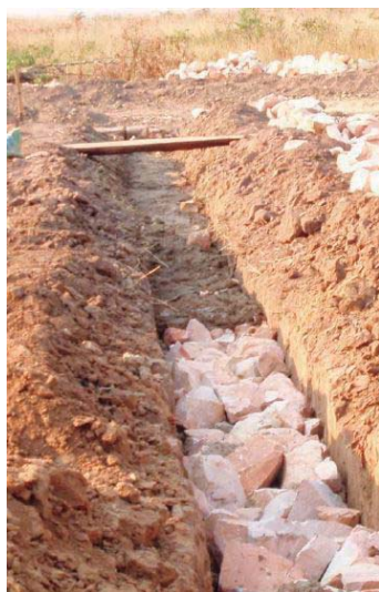
FIG78. Excavación de zanjas, colocación de la cama de arena y hormigón pobre, y realización de la cimentación con piedras del lugar.
