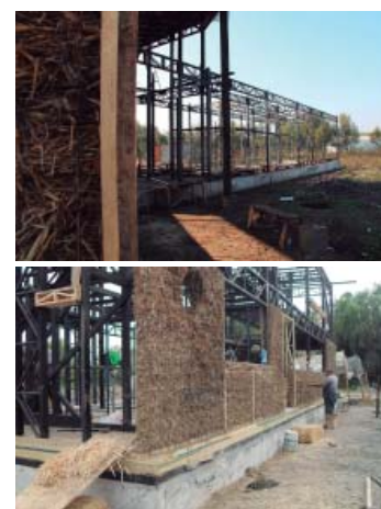
FIG68-69. Construcción Mixta Acero-Paja. ECoT (Escuela de Construcción en Tierra).
