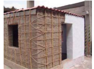
FIG52. Refuerzo con malla natural.
