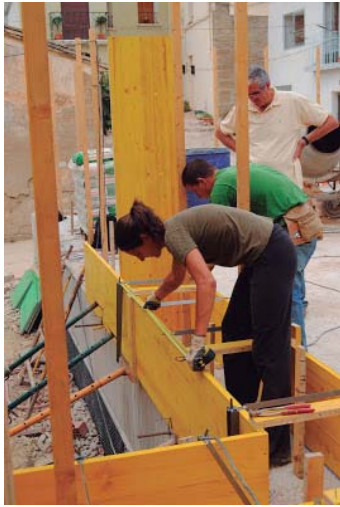
FIG30. Montaje encofrados.
