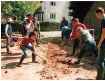
FIG48. Mezclado tierra.
