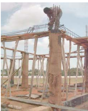
FIG23. Construcción de los pilares. Éstos se cubren con telas mojadas durante 3 semanas.
