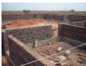
FIG80. Levantamiento de los muros.
