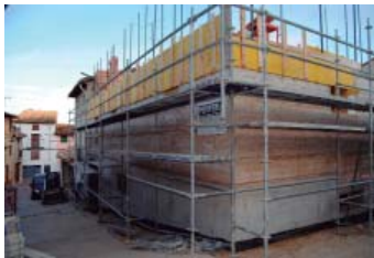
FIG31. Proceso construcción tapial.
