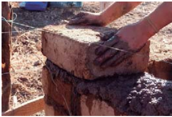
FIG37. Apilamiento adobes.
