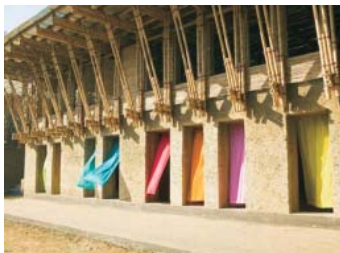
FIG50. Muros de COB y cubierta de bambú en la Handmade School de Rudrapur, India.
