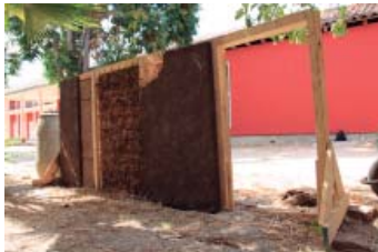
FIG66. Taller técnicas construcción mixtas Tierra-Madera, de ECoT (Escuela de Construcción en Tierra).
