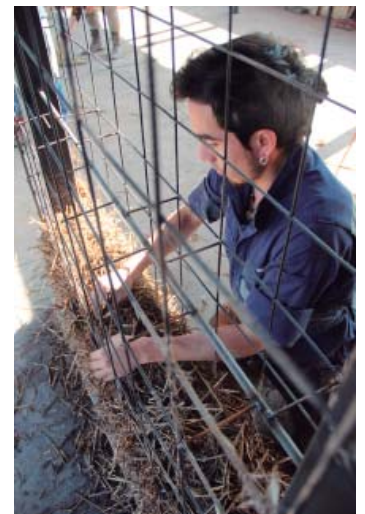
FIG70. Relleno de paja en entramado ligero de acero (semejanza con Cob+Steel Framing. ECoT (Escuela de Construcción en Tierra).
