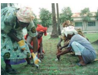
FIG24. Doblado del armado.
