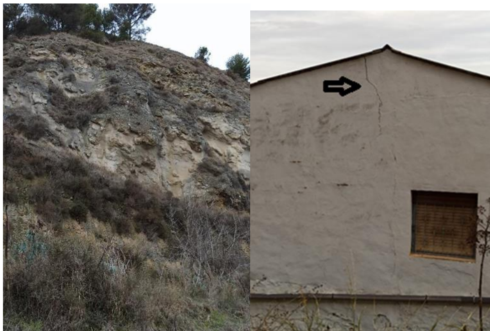
Figura 15. Gunitado en el deslizamiento 4 para contener el movimiento, a su lado, casa blanca con una grieta que divide la casa en dos frente al mismo deslizamiento. Fuente: (Elaboración propia).
