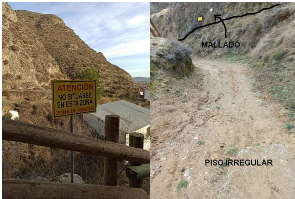
Figura 13 Cartel de atención, mallado y piso irregular en el deslizamiento 3 (D3). Fuente: (Elaboración propia).
