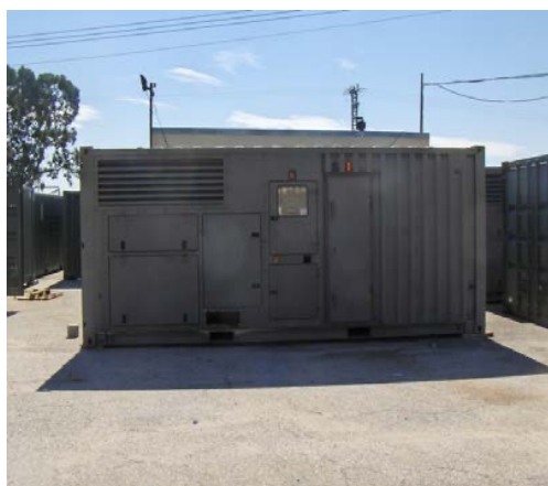
Ilustración 39. Instalaciones del campamento. Módulo de corriente eléctrica secundaria. Grupos electrógenos de 600 kVa.
