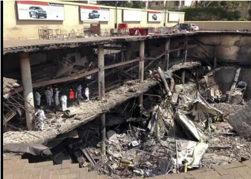
Investigadores forenses en la zona del parking del centro comercial Ap
