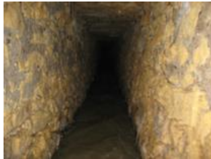
Ilustración 52. Colector con hastiales y bóveda de obra de piedra. Fuente: U.E.S.
