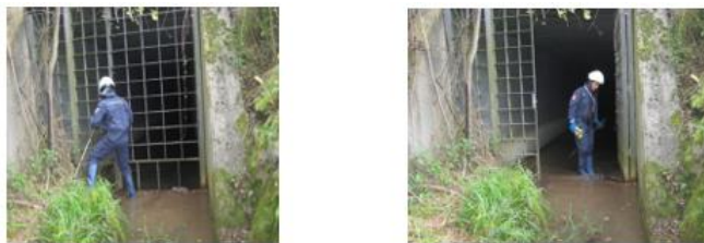
Ilustración 16. Agente de Policía, durante la fase de experimentación, accediendo al interior de un colector pluvial. Fuente: realizada por el autor.
