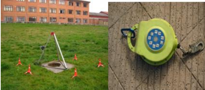
Ilustración 68. Montaje de un trípode sobre pozo de registro y anticaídas. Fuente: U.E.S.
