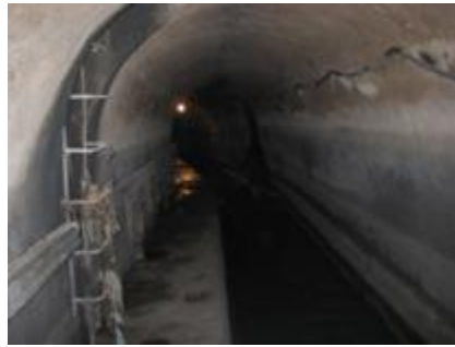
Ilustración 50. Colector de aguas residuales con cuna y un andén. Fuente: U.E.S.
