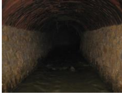
Ilustración 53. Colector con hastiales de obra de piedra y bóveda de ladrillo. Fuente: U.E.S.
