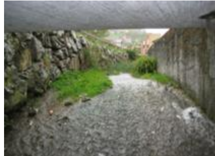
Ilustración 47. Cabecera de colector de aguas pluviales. Fuente: U.E.S.
