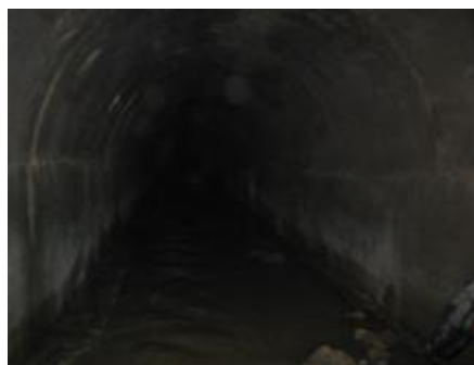
Ilustración 49. Colector de aguas residuales solo con cuna. Fuente: U.E.S
