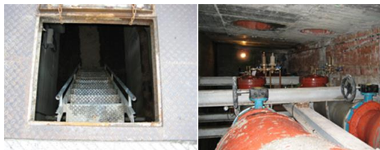
Ilustración 22. Entrada e interior de un habitáculo de agua potable. Fuente: realizada por el autor.
