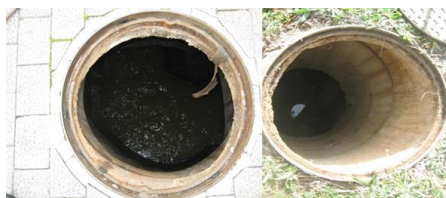
Ilustración 26. Bajada de pozo registro sin pates. Fuente: realizada por el autor.
