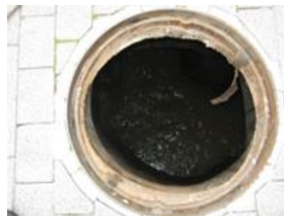
Ilustración 61. Bajada de pozo de registro sin pates. Fuente: U.E.S.
