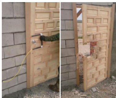
Ilustración 32. Carga confeccionada con PVC para la apertura de una puerta. Fuente: (VII, 2019).
