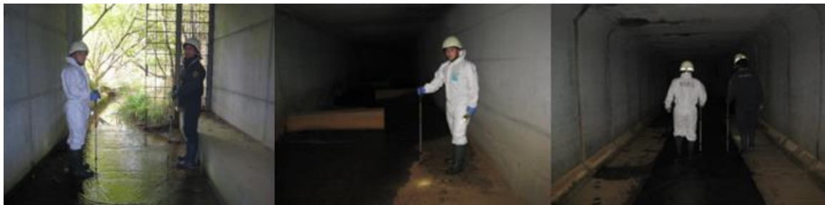
Ilustración 17. Agente de Policía, junto al autor del trabajo, en la entrada de un colector pluvial, con la puerta de acceso abierta y en el interior de este. Fuente: realizada por el autor.
