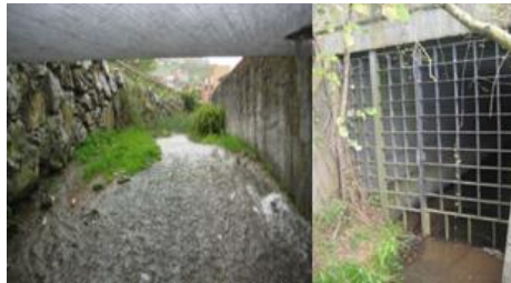
Ilustración 15. Cabecera de colector de aguas pluviales. Fuente: U.E.S.
