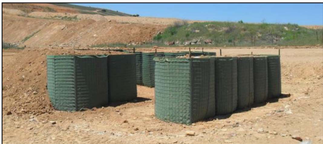
Figura 3: Ejemplo de ZA realizada con Hesco-Bastion. (Fuente: Anexo B I.T. 0301/12)
