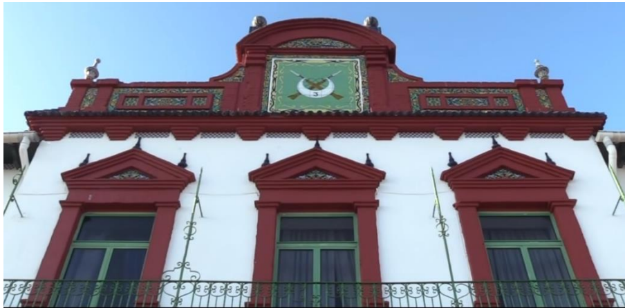
Figura 1: Fachada principal del patio de armas del acuartelamiento González Tablas. Fuente: Elaboración propia.
