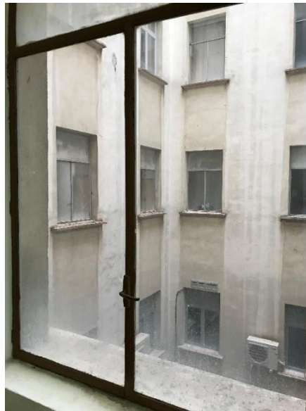
Ilustración 16. Ventana del edificio de PLMDD. Fuente: elaboración propia
