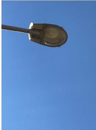
Ilustración 7. Luminaria exterior sobre soporte viario, bombilla de vapor de sodio de alta presión. Fuente: elaboración propia
