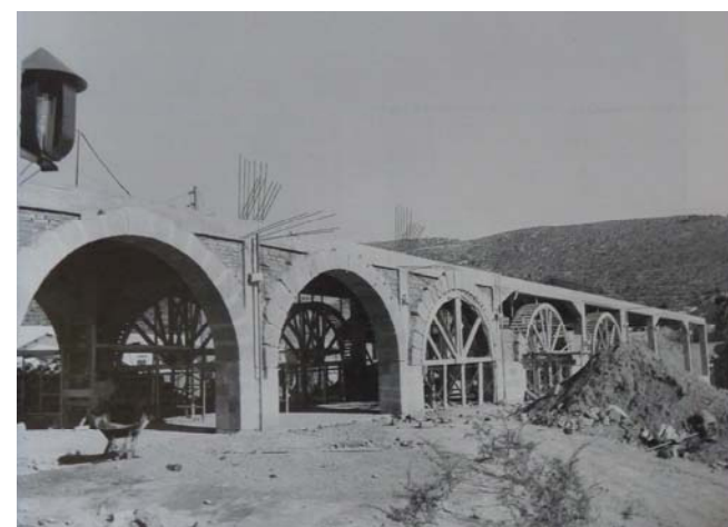
Fig. 104. Construcción de arcos con cimbras de madera.
