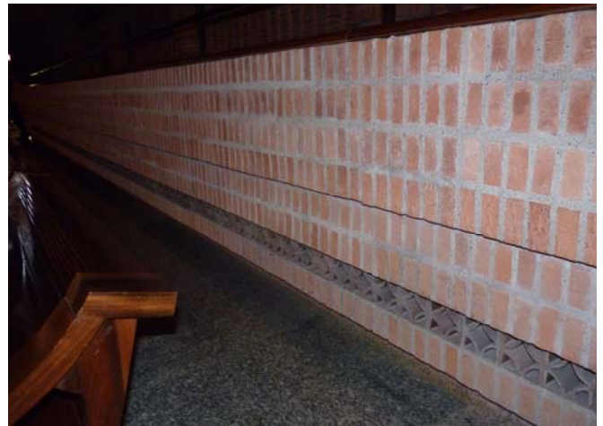
Fig. 86. Celosía que cubre instalaciones de ventilación. (Fotografía del autor)
