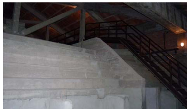
Fig. 134. Estructura de cubierta. Cercha y bóveda de Hormigón. (Fotografía del autor)
