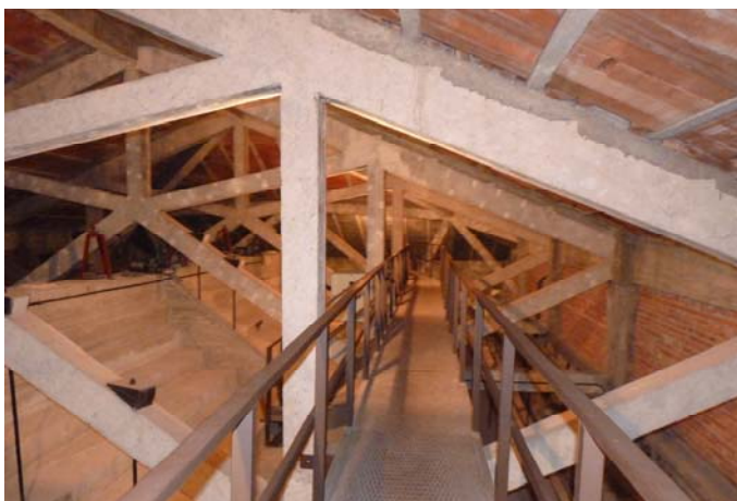
Fig. 135. Estructura de cubierta. Cercha de Hormigón. (Fotografía del autor)
