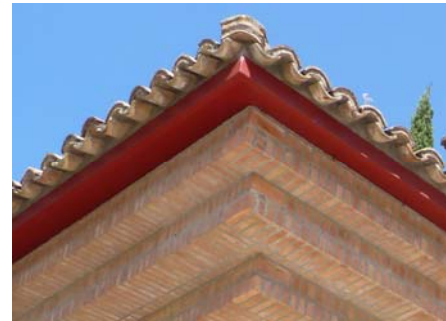
Fig. 124. Encuentro de ladrillos en esquina. (Fotografía del autor)
