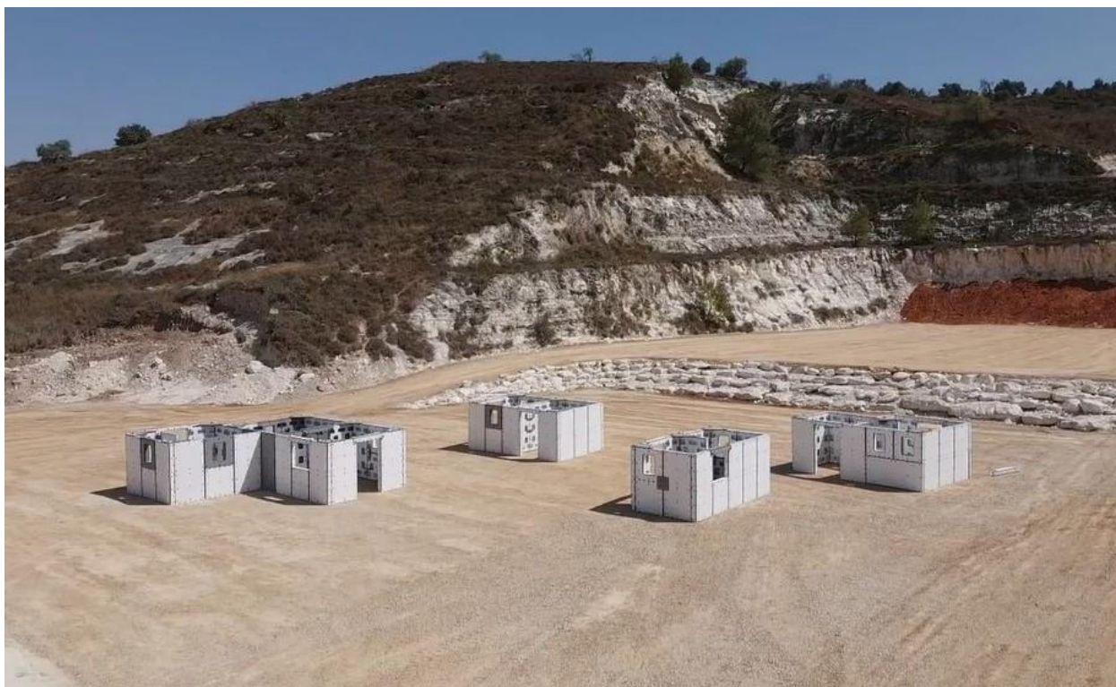
Ilustración 16: Ejemplo de edificación (2). Fuente: https://www.trango-sys.com/
