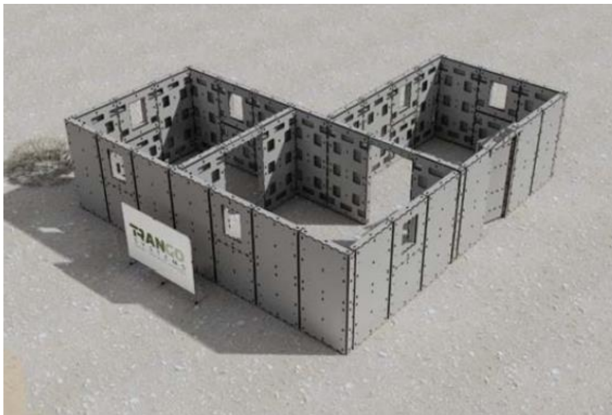
Ilustración 13: Ejemplo de pequeña edificación. Fuente: https://www.trango-sys.com/
