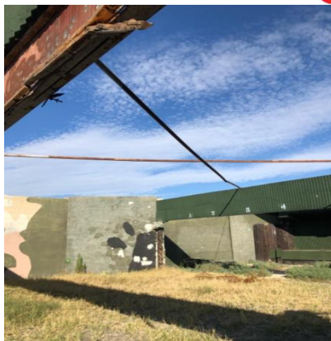
Figura 23. Estado de los parabolas superiores y de la cruz de San Andrés (Elaboración propia)
