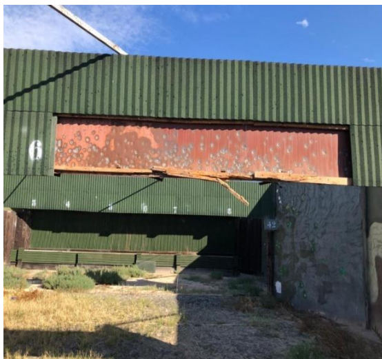
Figura 22. Fotografía del estado de los parabolas superiores. (Elaboración propia)
