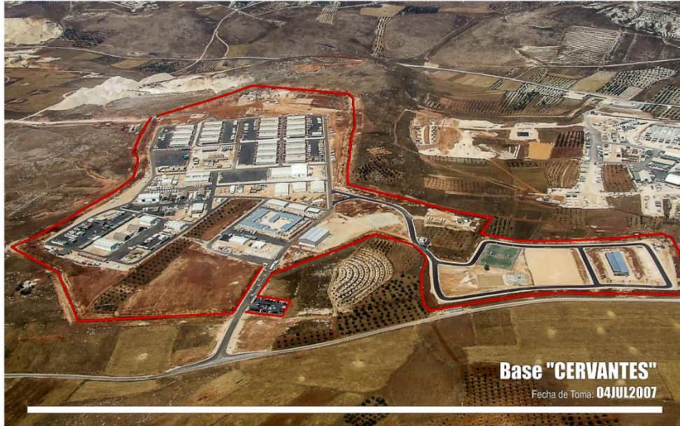
Figura 6: Base Miguel de Cervantes, Líbano. Base construida por ingenieros zapadores pertenecientes al REI 11. Está considerada la mejor base de las que dispone la Organización de Naciones Unidas. Fuente: ejercito.defensa.gob.es en "Regimiento de Especialidades Nº 11. Unidades en operaciones".
