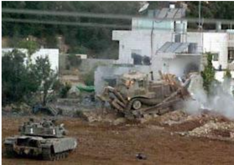
Figura 23: Buldócer israelí atacando edificaciones en una operación similar a la de Hebrón. Fuente: fdra.blogspot
