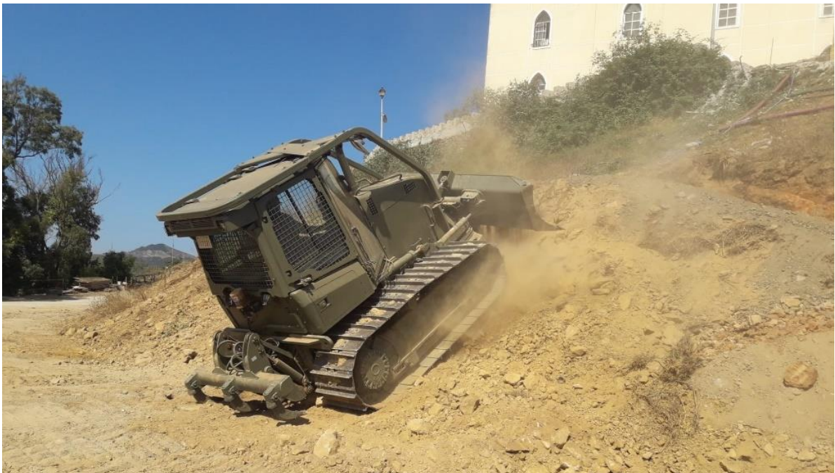
Figura 3: Dozer Caterpillar D5k2, del Regimiento de Ingenieros nº7, realizando ejercicios de movimiento de tierra para la construcción de una obra. Fuente: jefe del ejercicio.
