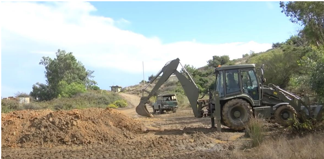
Figura 5: Retroexcavadora JCB del Regimiento de Ingenieros nº7 realizando un abrigo para vehículo en una posición defensiva, para mejorar las condiciones de seguridad del personal y material. Fuente: Periódico local El Faro de Ceuta.
