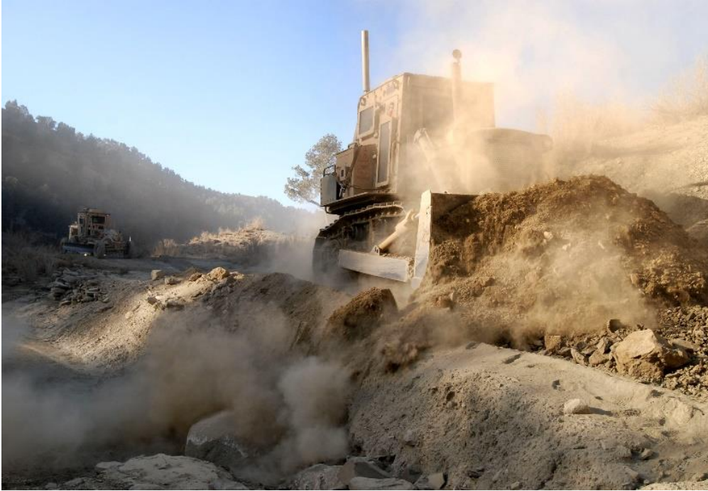
Figura 4: Bulldozer estadounidense rehabilitando una ruta para su uso logístico en Paktika, Afganistán. Fuente: U.S. Department of Defense.
