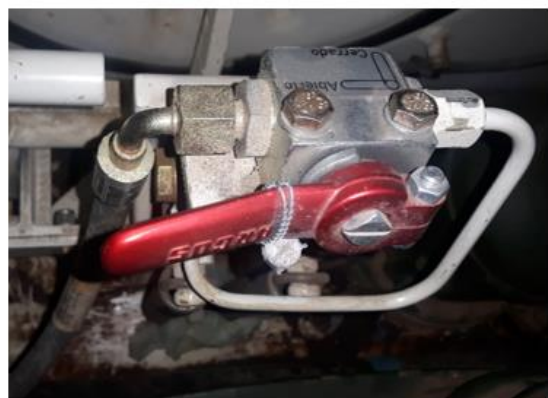
Figura 23. Esquema del puenteo de la llave de descontaminación NBQ, con la servoválvula conectada al sistema contraincendios. Fuente: Instalación del Programa Integral de refrigeración
