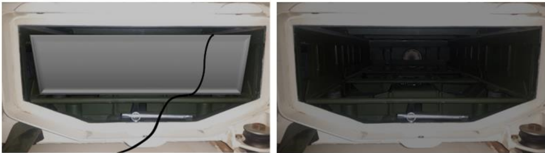
Figura 25. Compartimento del Sistema NBQ del CC Leopardo 2E, equipado o no con el refrigerador casero.
