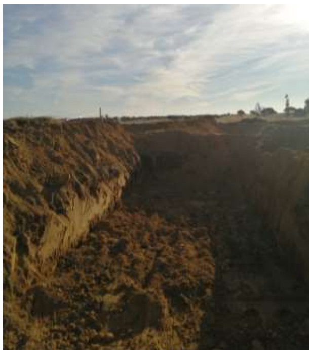
Figura 44. Fotografía de una zanja del diseño "C"
