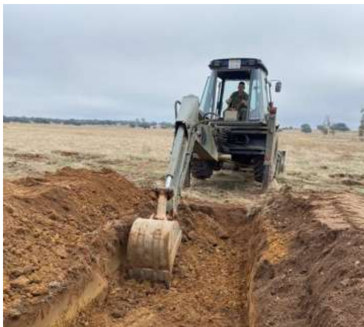
Figura 29. "Retrocargadora Mixta JCB" realizando excavación del foso ajedrezado
