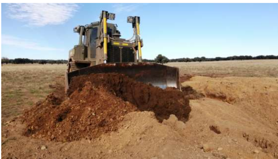
Figura 57. Fotografía de la "Bulldozer Caterpillar D7-R" retirando el diseño "C"
