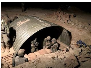
Figura 9. Zapadores de la Brigada Aragón montando un refugio enterrado. Fuente: ET.
