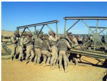
Figura 8. Zapadores de la Legión se forman en el montaje del puente Bailey. Fuente: BZAPLEG.
