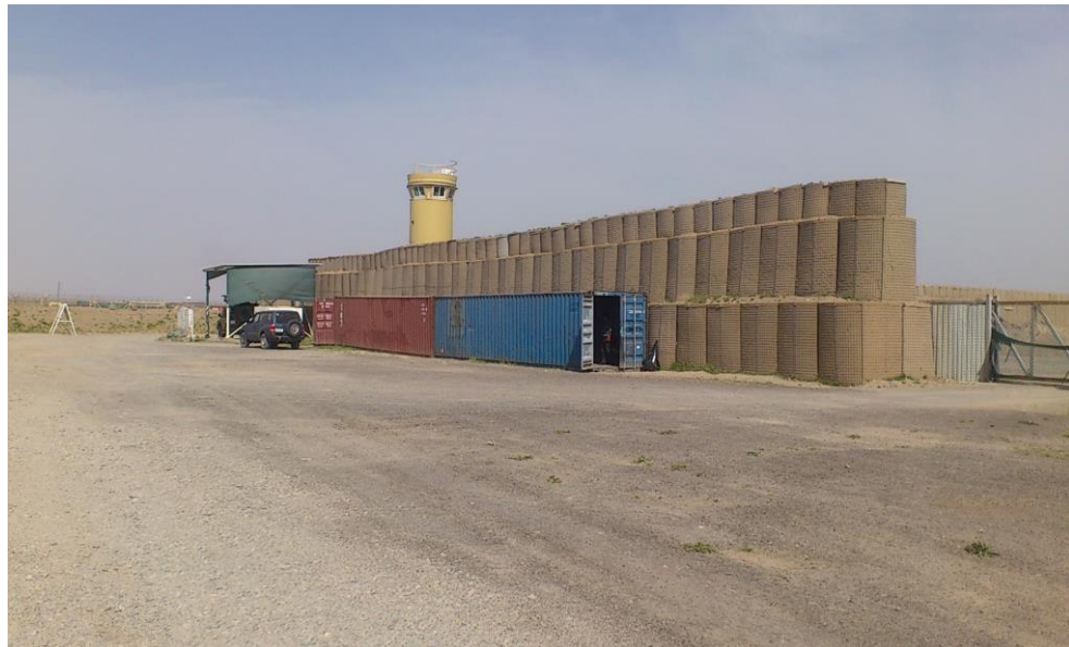
Imagen 8, centro de comunicaciones.
