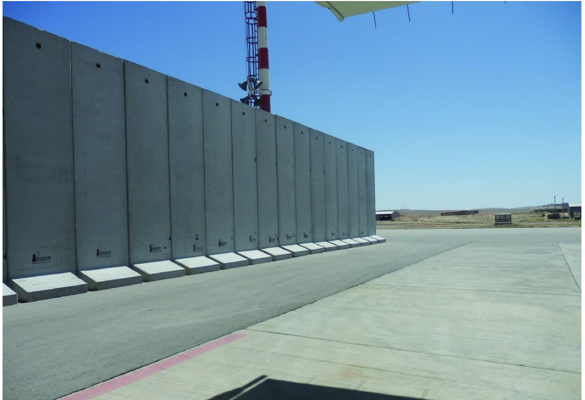
Imagen 30, muros T-Wall. Fuente: Cap. Pelayo.
