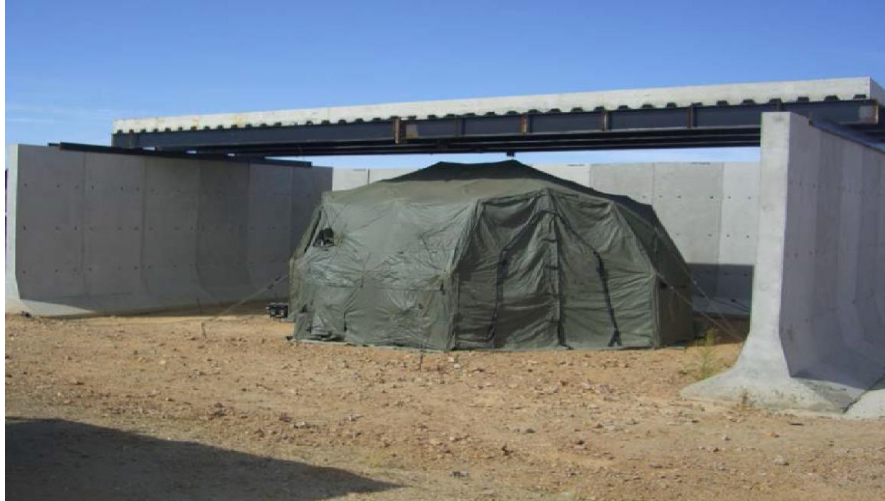
Imagen 31, estructura en base a T-Wall. Fuente: Tte. Coll Mora.
