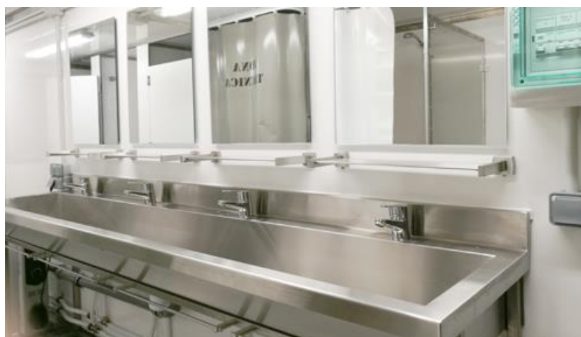
Figura 10. Contenedor Ablución. Detalle lavabos. Fuente: Hispanovema.
