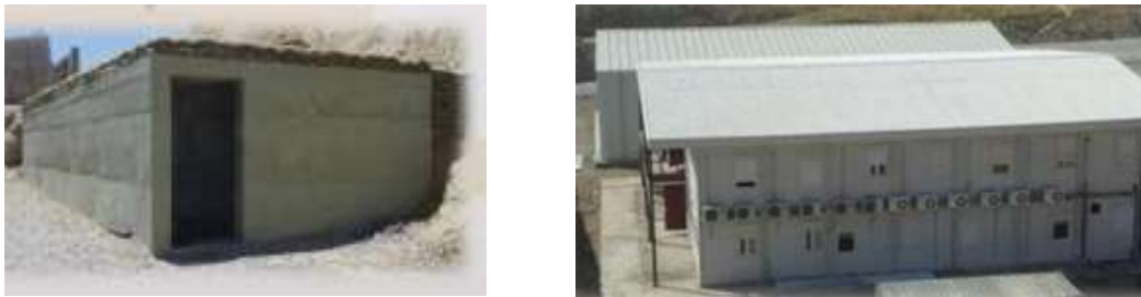
Figura 29. Refugios de Hormigón.
