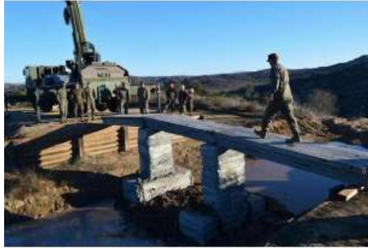
Figura 13. Puente de hormigón.
