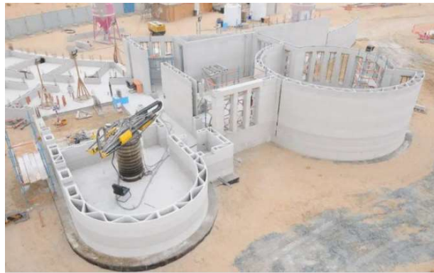
Figura 11. Edificio impreso por Apis Cor en Dubai.
