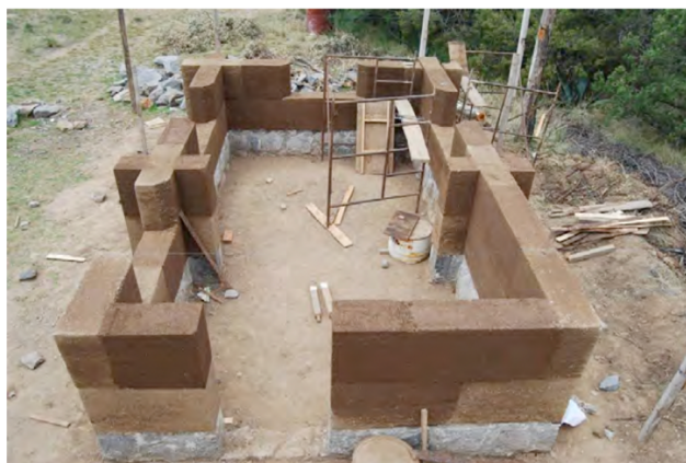
Figura 8 Edificación realizada con tapial de tierra estabilizada
