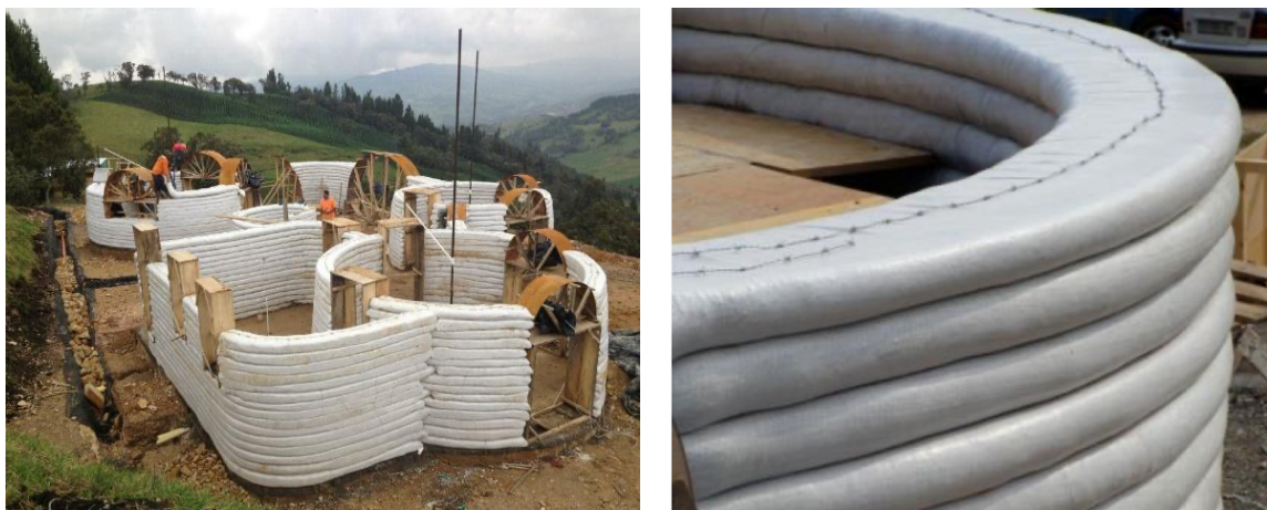
Figura 10 Edificación de superadobe
