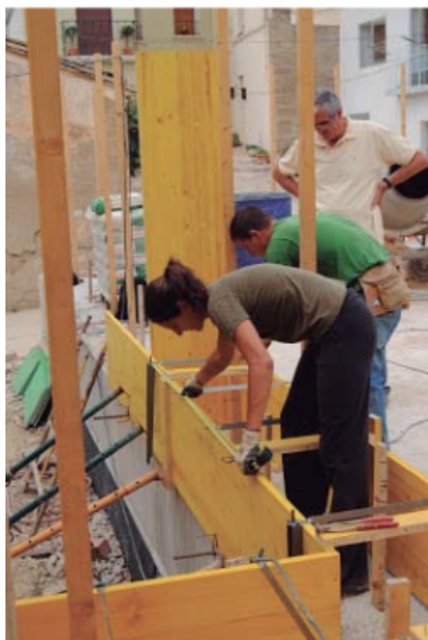
Figura 7 Montaje de encofrados para tapial de tierra
