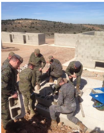
Figura 1 Construcción del PICOZU por medio de bloques de hormigón
