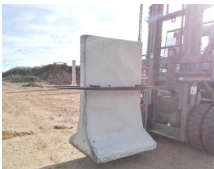
Ilustración 8: Transporte T-Wall
