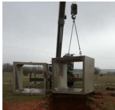
Ilustración 11: Refugio con T-Wall y cubierta de hormigón
