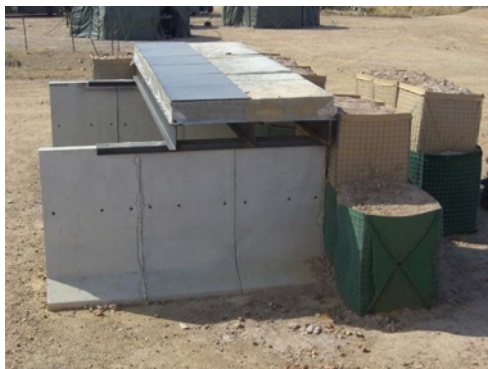
Ilustración 10: Abrigo enterrado en base a prefabricados
