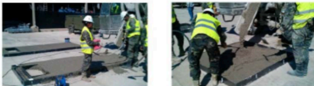
Ilustración 6: Hormigonado moldes Fuente: : (Cuartel General del Mando de Ingenieros, 2018)
