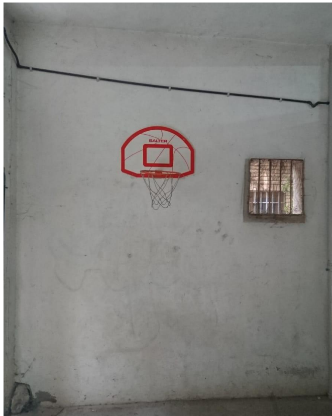
Anexo XXVIII – Muro interior del garaje sobre el que decidí plasmar mi obra personal para el trabajo de fin de grado.
