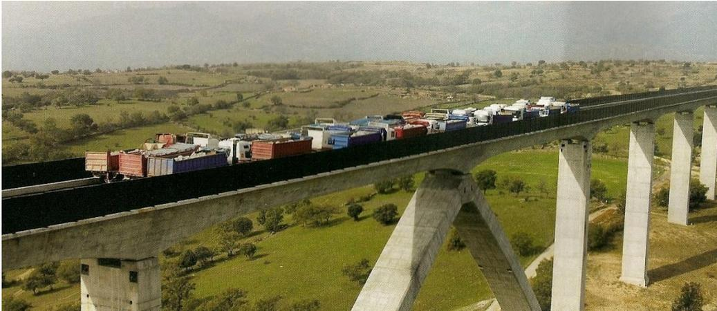
*Fig.36. Pruebas de carga en el viaducto de Arroyo del Valle (Fuente, Vía Libre).*
